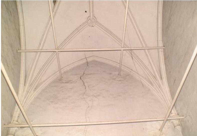
Figura 7: Tirantes em aço colocados ao nível do teto do 1º piso. (foto cedida pela DRAC)
