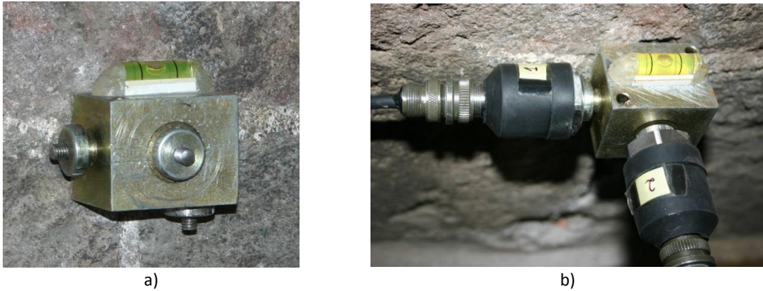
Figura 26: Sensores: a) Nivelamento para a colocação dos sensores; b) Sensores de referência (1 e 2), colocados no Piso 3- Sala dos Sinos
