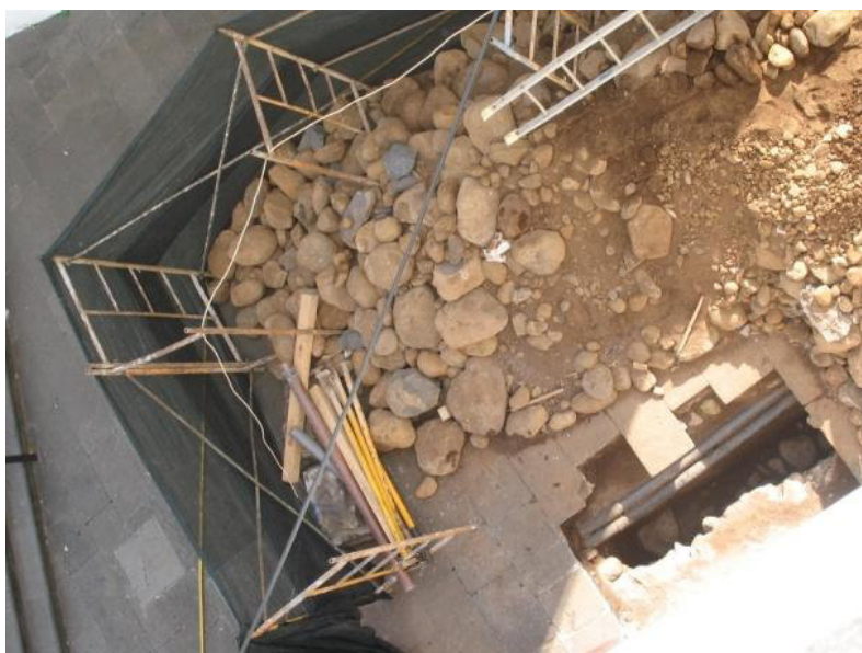
Figura 6: Material removido das fundações na realização dos poços de inspeção na realização relatório da A2P (foto cedida pela DRAC)
