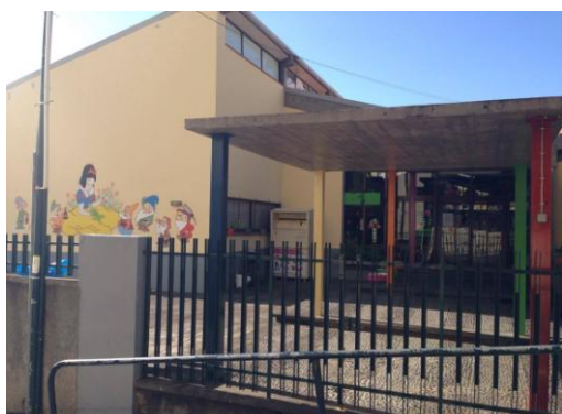
Figura 6. Fachada do Anexo da Azinhaga
