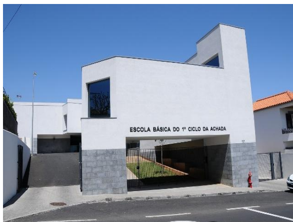
Figura 57. Fachada da EB1/PE da Achada
