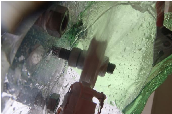
Figura Q.34 – Detalhe da escapatória da água.
