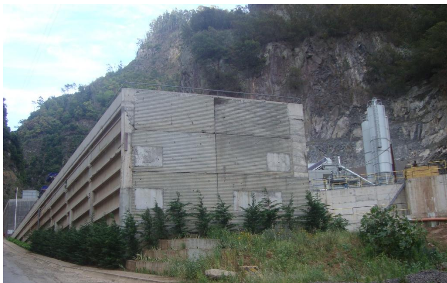
Figura 2. Localização da parede a construir futuramente (Fundoa, Madeira).
