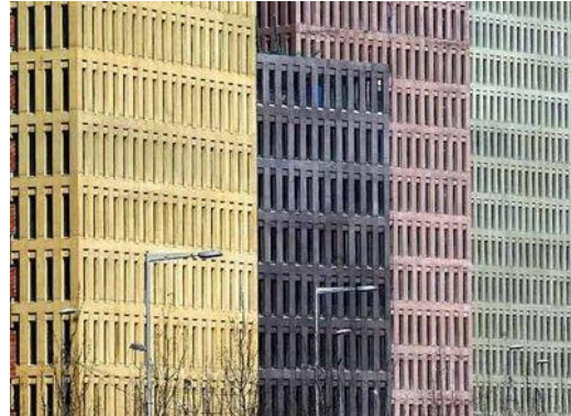
Figura 4. Ciudad de la Justicia (Arquitecto David Chipperfield) (fonte: [7]).
