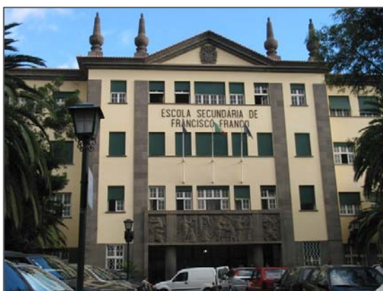
Fig. 2 - Escola Secundária Francisco Franco (vista exterior)
