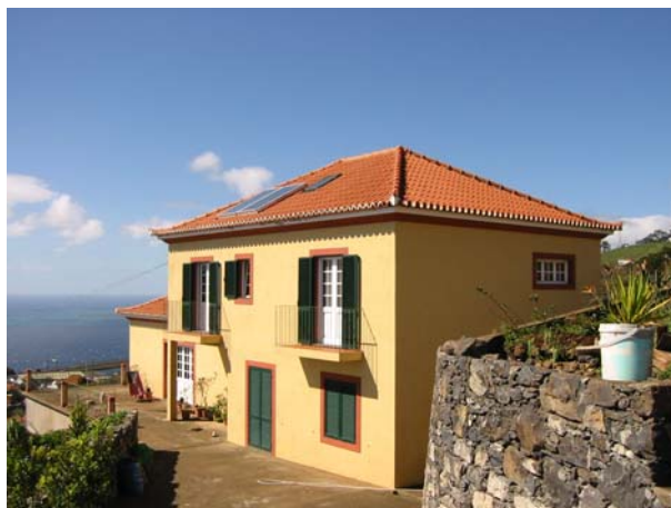
Figura 1.24 Instalação solar térmica participada pelo SIEST
