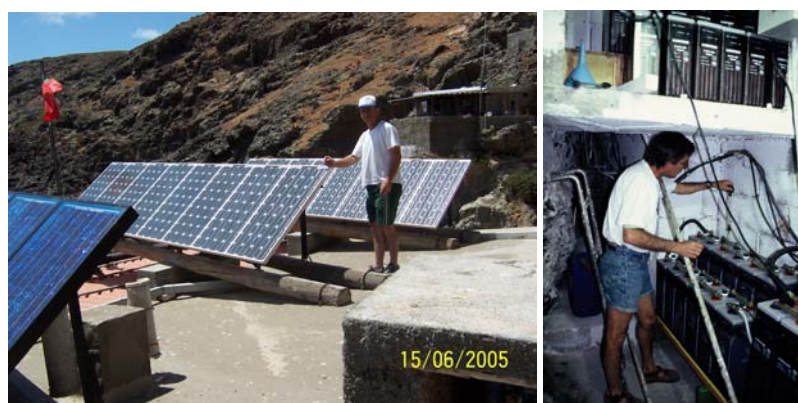
Figura 2.18 Selvagem Grande, visita de manutenção
