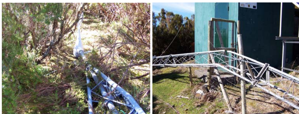
Figura 2.36 Aerogerador acidentado por ventos muito fortes
