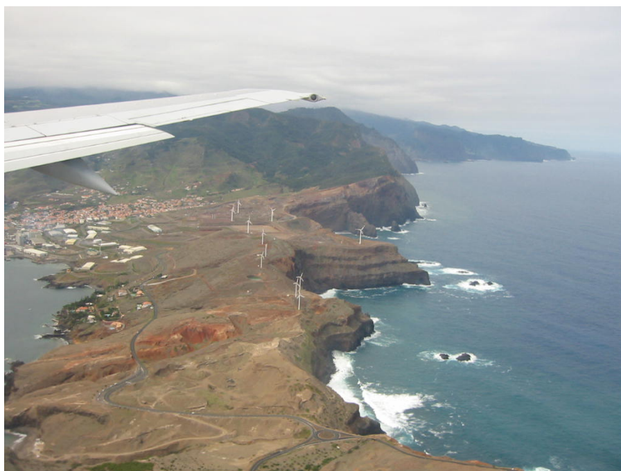
Figura 2.7 Parques eólicos do Caniçal em 2001
