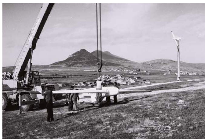
Figura 1.2 Porto Santo, pormenor de montagem do primeiro parque eólico de Portugal
