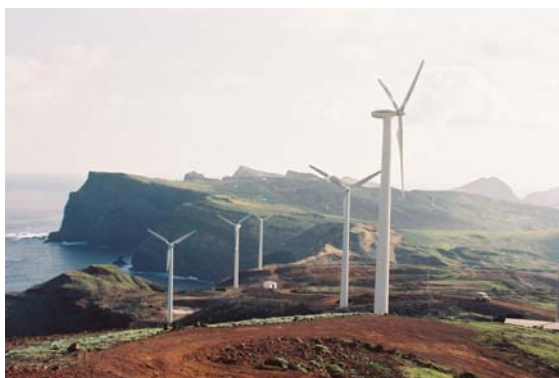
Figura 1.19 Parque eólico do Caniçal
