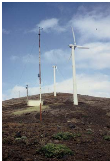
Figura 2.6 Caniçal, p.e. e estação anemométrica MD-21
