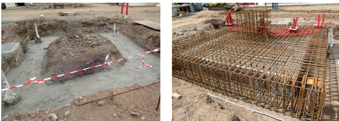
Figura 4.19 – Fundações das antenas com um maciço com 4 micro-estacas.
