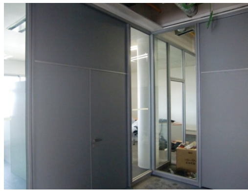
Figura 4.11 – Cristal Movinord para as paredes divisórias vindo de Espanha
