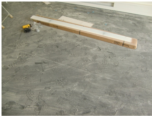
Figura 4.14 - Pavimento Vinílico Forbo aplicado na sala de reuniões e escritórios administrativos, vindo da Holanda
