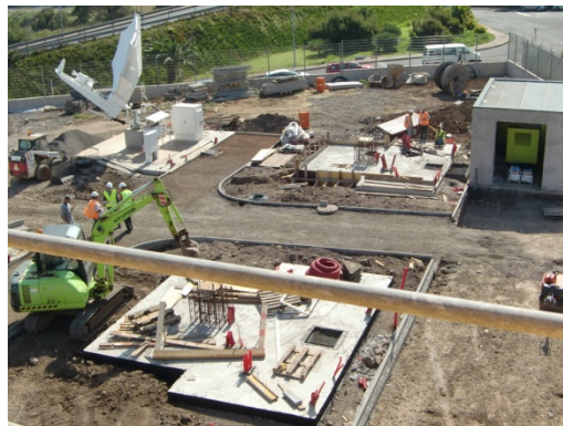
Figura 4.8 – Preparação dos maciços para a colocação de duas antenas
