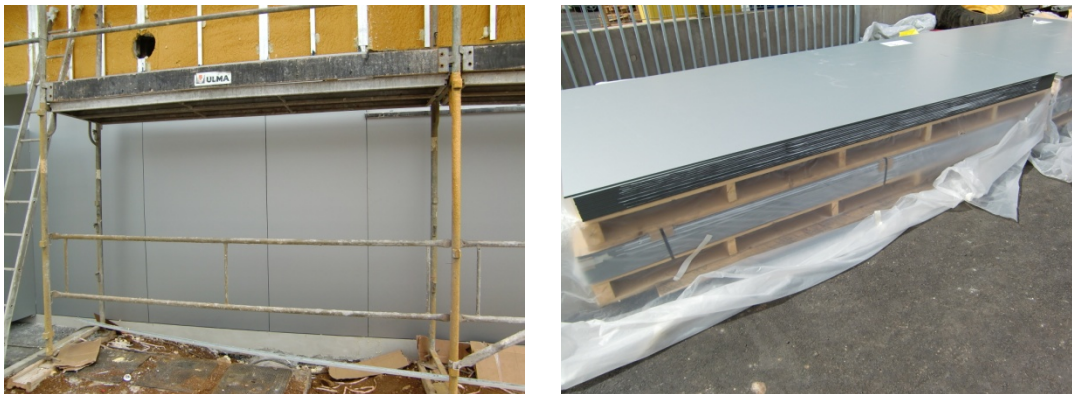
Figura 4.12 – Painéis Fenólicos Exteriores Trespa para o revestimento exterior do edifício vindo da Alemanha.
