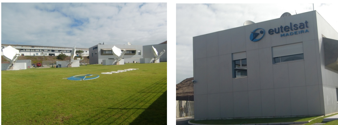
Figura 4.22 – Conclusão da execução do edifício Eutelsat Madeira
