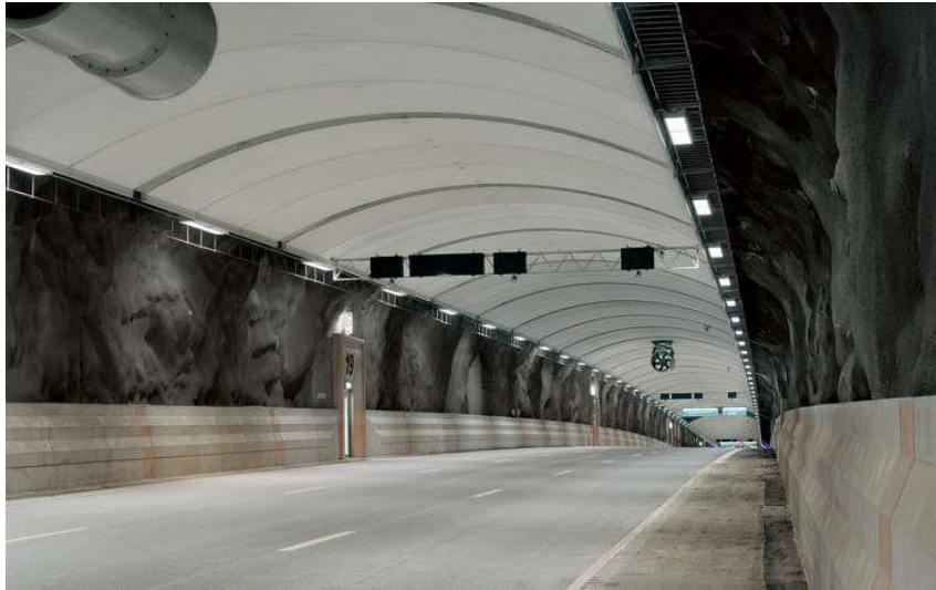
Figura 2-3 – Sodra Lanken Tunnels, em Estocolmo.
