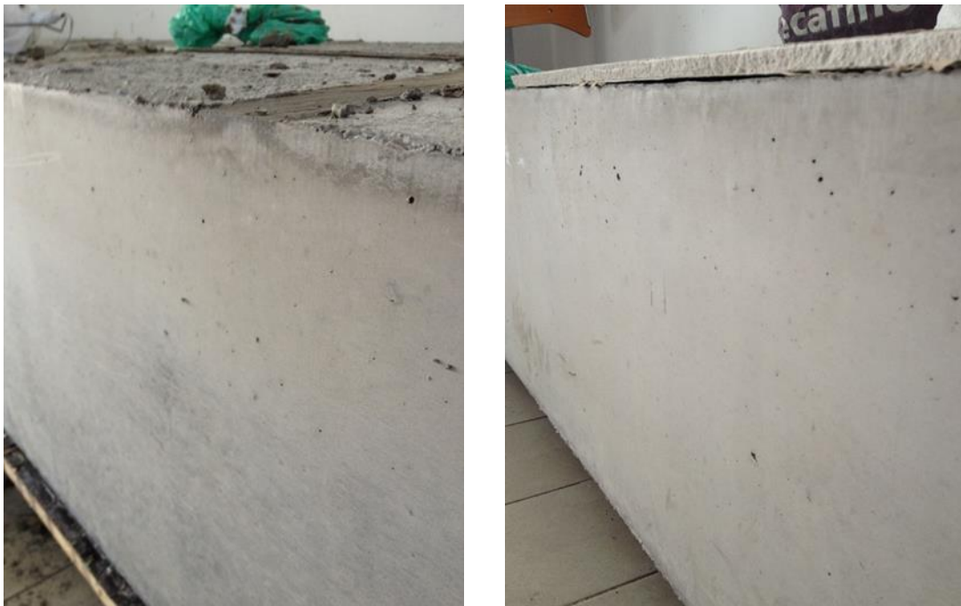
Figura 6-7 - Superfície das vigas betonadas com BAC na 1ª e 2ª fase.
