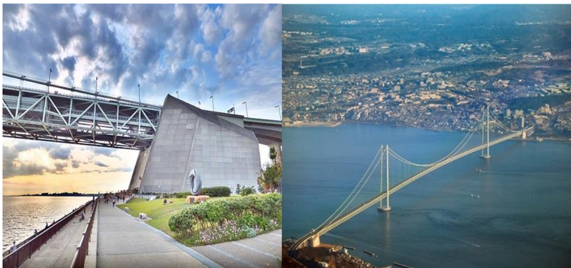
Figura 2-1 – a) Ancoragem da ponte suspensa de Akashi-Kaikyo; b) Aspecto final da ponte.
