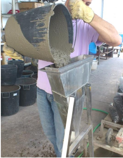
Figura 4-25 – Preenchimento do funil V com betão.
