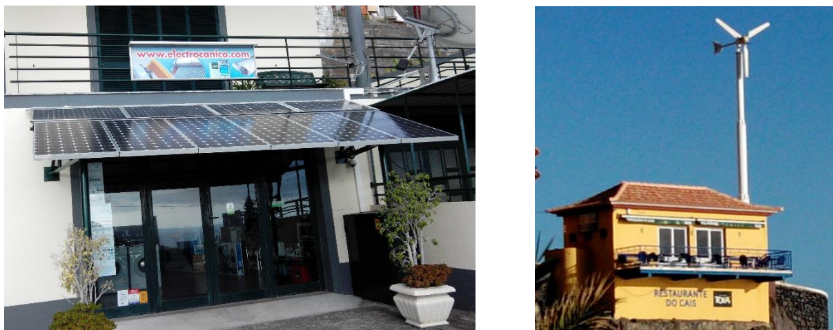
Figura 4.13 – Microgeração com incorporação em pala na zona do Caniço e por meio de energia eólica na Ponta de Sol
