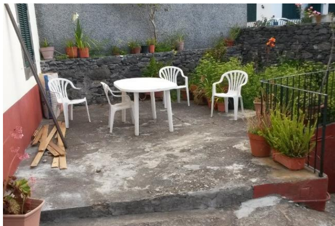
Figura 6.5 – Local para a montagem dos pré-fabricados
