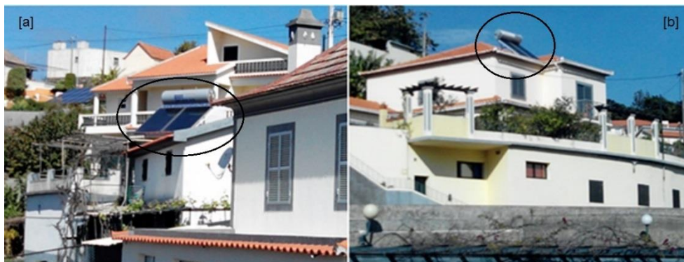
Figura 4.2 – Exemplos de termosifão na região: [a] zona dos Canhas; [b] em frente à Universidade
