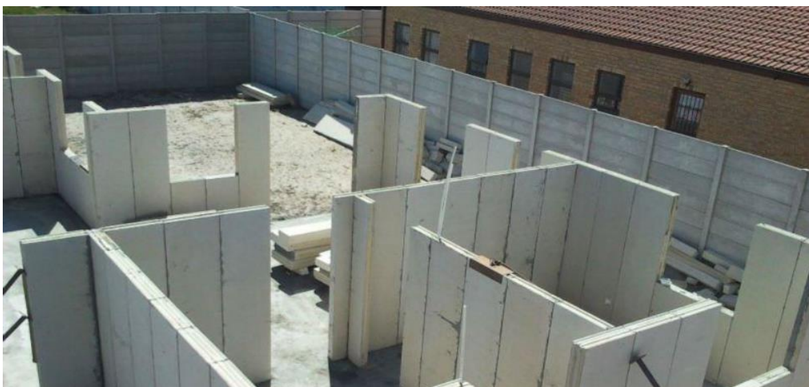
Figura 2.23 – Montagem dos Painéis.
