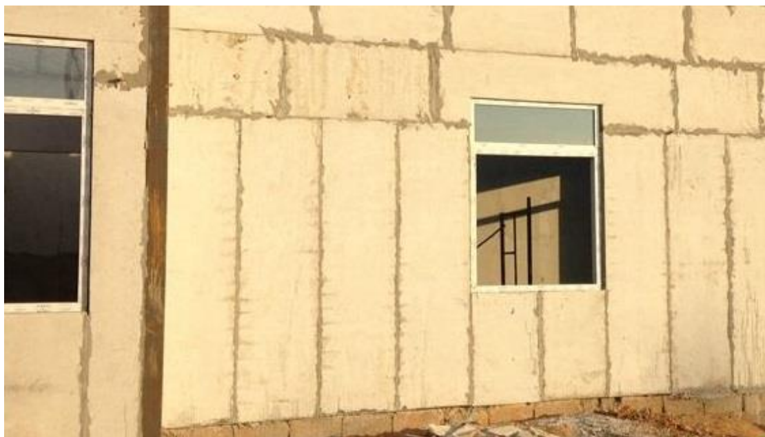
Figura 2.29 – Pormenor de Painéis previamente cortados e montados para incorporar uma janela.
