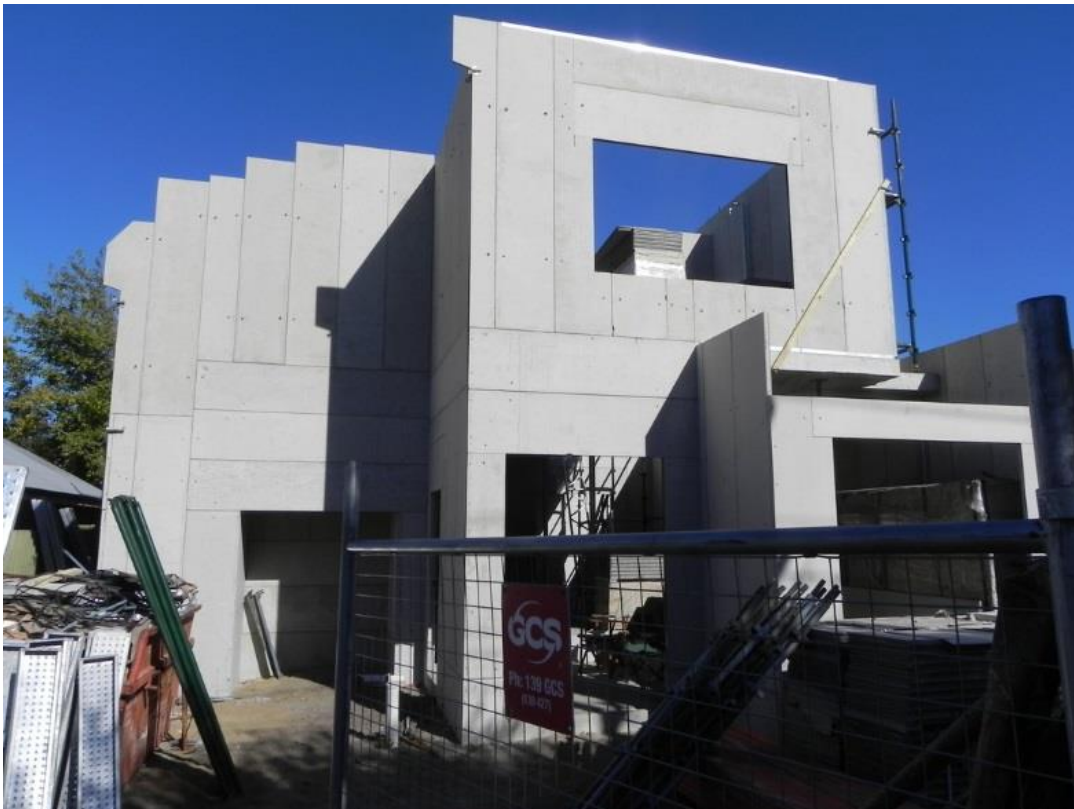
Figura 2.36 – Habitação construída com Painéis em Leerderville, Austrália.
