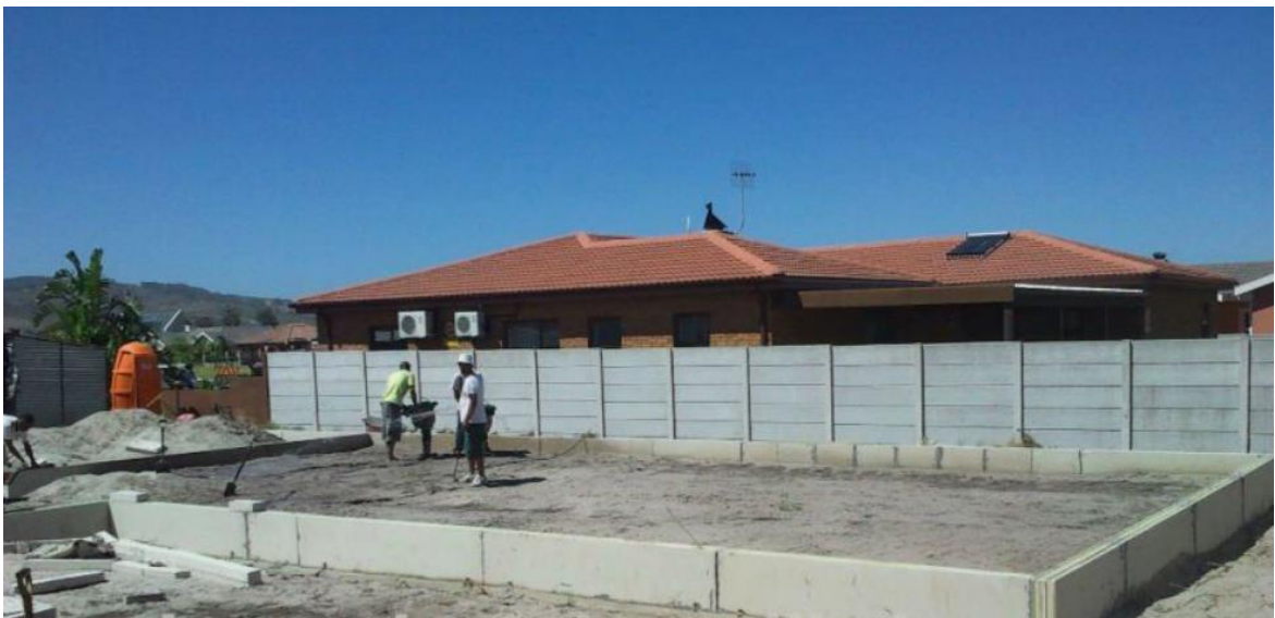
Figura 2.22 – Painéis utilizados como cofragem para ensoleiramento geral.
