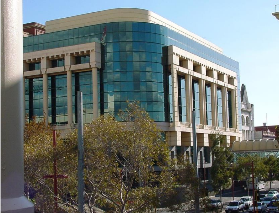
Figura 2.35 – Painéis curvos desenhados especificamente para a fachada exterior e cobertura do edifício Albert Facey House em Perth, Austrália.
