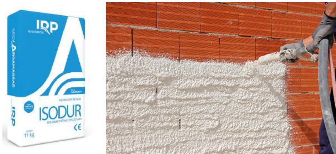
Figura 2.46 – Embalagem e aplicação de argamassa ISODUR.
