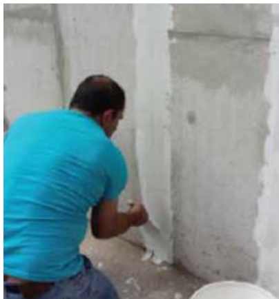
Figura 5.20 – Aplicação da argamassa de colagem.
