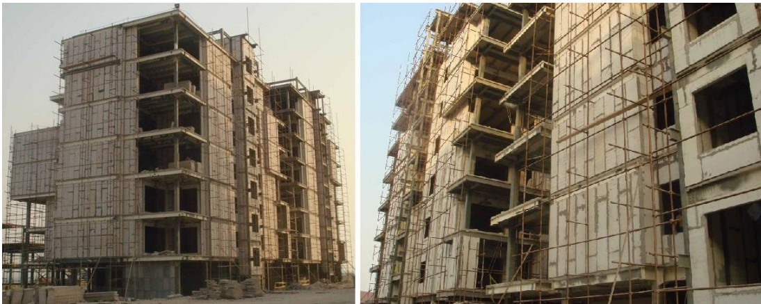
Figura 2.27 – Aplicação de Painéis em paredes não estruturais.
