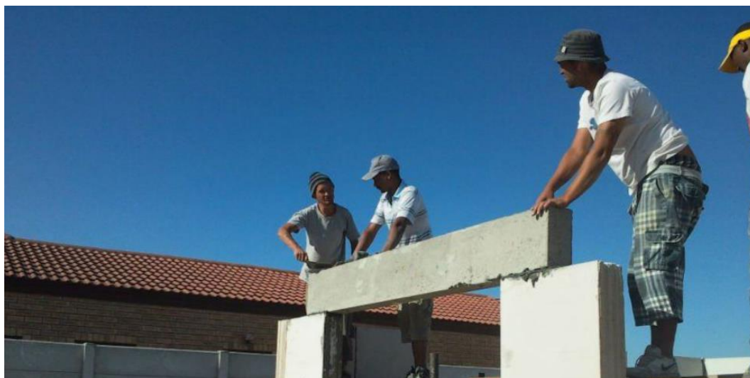
Figura 2.24 – Colocação de um Painel horizontalmente na parte superior de uma janela.
