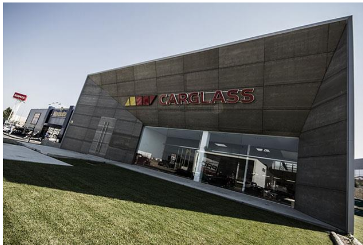
Figura 2.41 – Painéis Viroc em fachada exterior. Armazém Carglass, Portugal.
