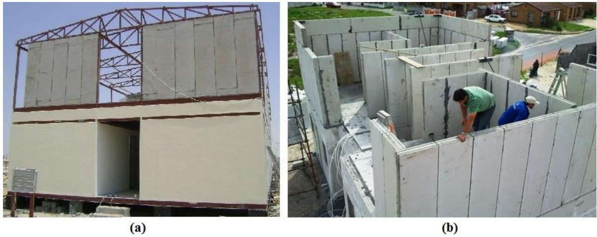
Figura 2.31 – Montagem de: (a) paredes de fachada; (b) paredes de fachada e divisórias.
