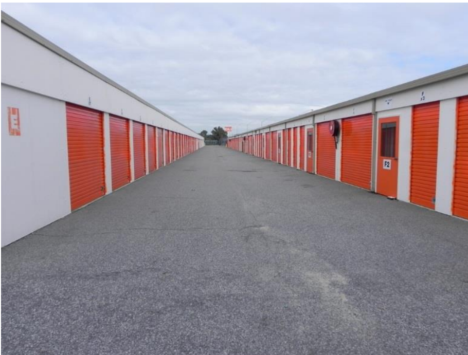
Figura 2.34 – Armazém construído em 6 semanas com Painéis. Koala Storage , Austrália.
