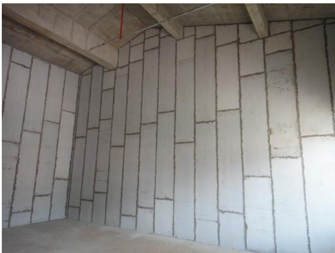
Figura 2.30 – Parede divisória num piso térreo.
