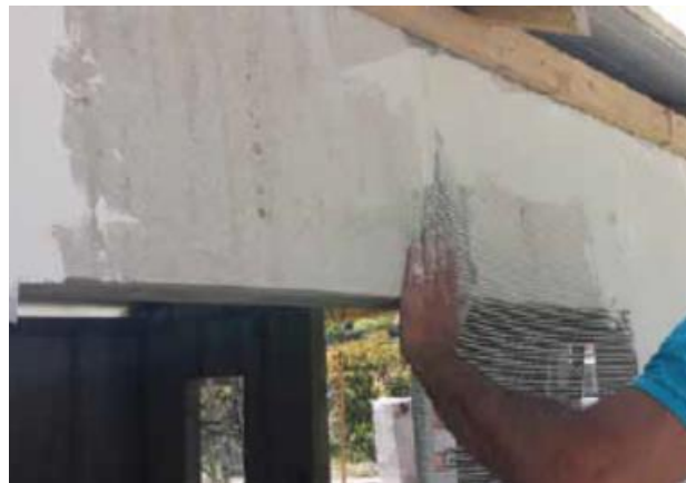
Figura 5.21 – Aplicação da rede de fibra de vidro, na segunda camada de argamassa ainda fresca.
