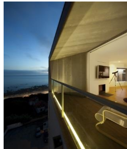
Figura 2.42 – Painéis Viroc em fachada exterior e cobertura. Apartamento Warborn, Portugal.
