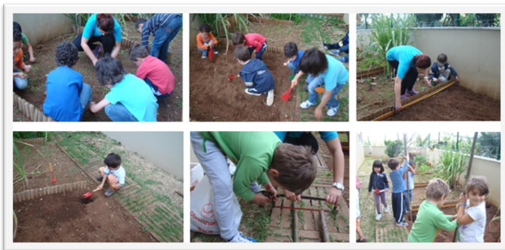
Figura 41. Trabalhos de limpeza e início de construção da estufa.
