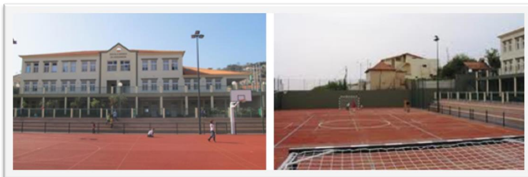
Figura 8. Fachada principal da EB1/PE da Assomada e campo de jogos.
