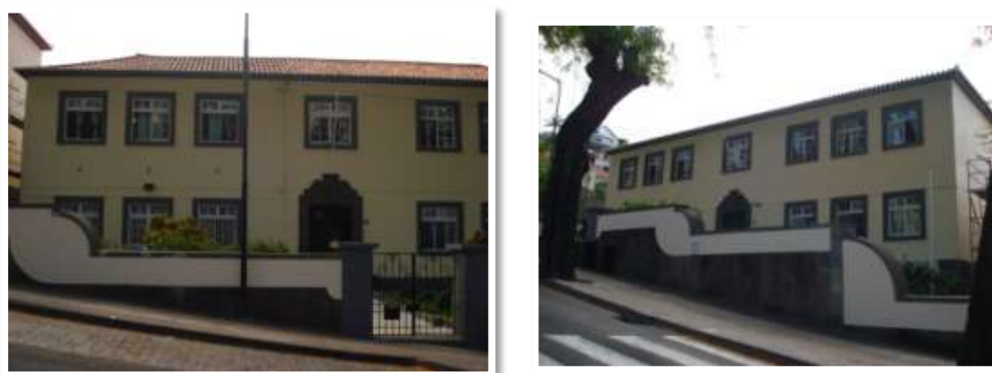
Figura 2. Edifícios da EB1/PE da Pena.
