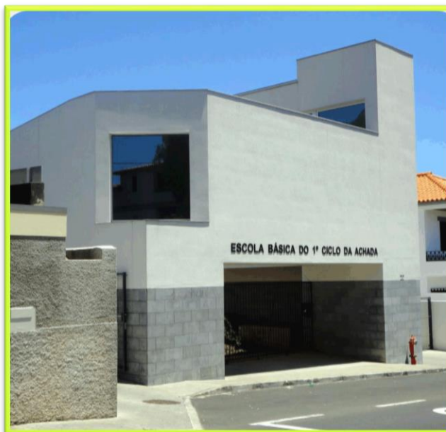
Figura 23. EB1/PE da Achada
