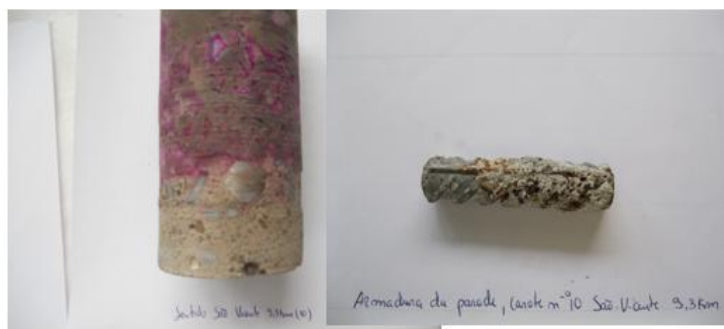
Figura 50 – Profundidade de carbonatação superior ao recobrimento e constatação do início do processo de corrosão
