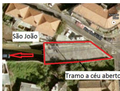
Figura 42 – Visualização do tramo construído a céu aberto [Google Maps]
