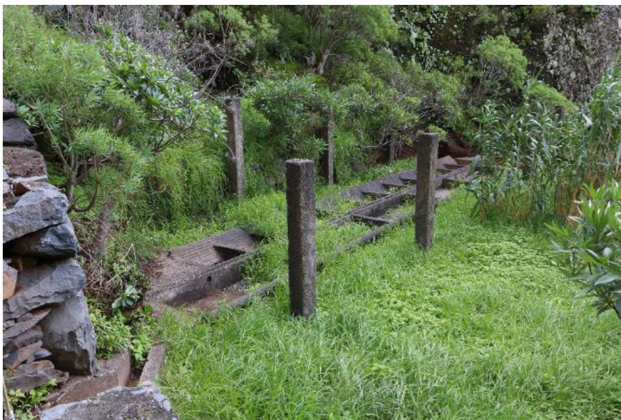
Figura 70 – Estrutura de lavagem de roupa coberta por vegetação
