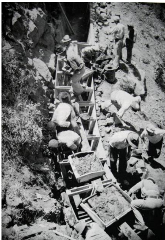
Figura 2 – Trabalhadores a construírem uma porção da Levada do Norte, escavando a rocha para a criação do canal. (Fotografia Perestrellos 1960)
