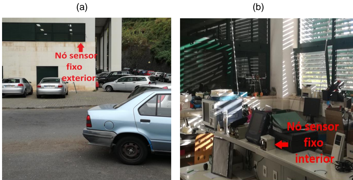
Figura 5.3 – Nós sensores fixos: a) Exterior. b) Interior.
