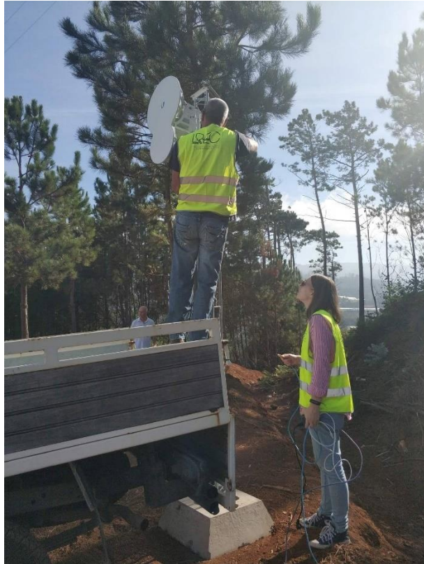
Figura 41- Montagem da antena master .
