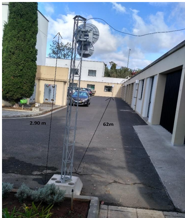
Figura 30- Montagem das antenas AirFiber 24GHz no recinto do LREC.
