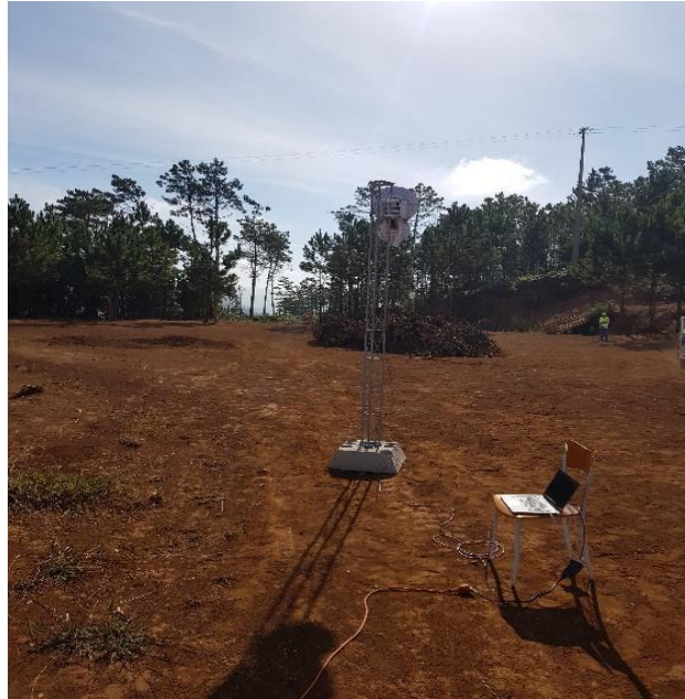
Figura 43- Alinhamento das antenas.
