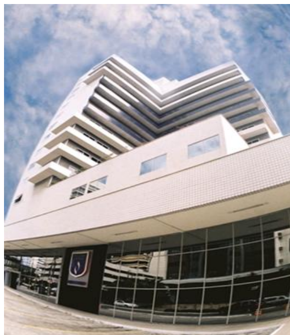
Figura 3 – Prédio Centro Universitário Christus.
