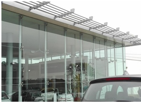
Figura 9 - Fachada em vidro. Santa Quitéria.
