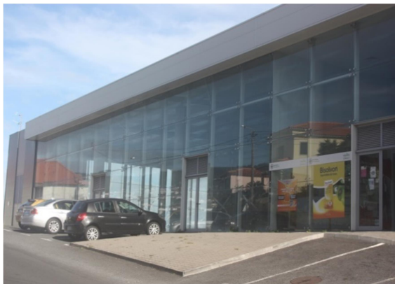
Figura 8 - Fachada em vidro. Santa Cruz.
