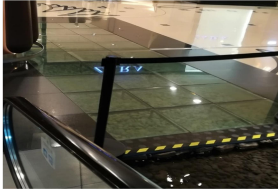
Figura 7 - Pavimento no Madeira Shopping.
