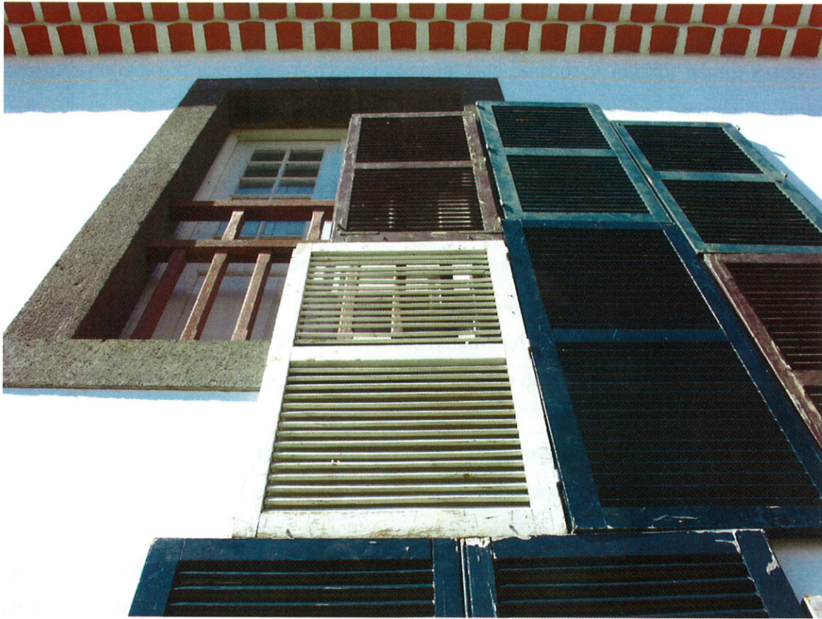
Figura 14 - Existe um muro capaz de impedir a bisbilhotice? 60 . 2007. Instalação de tapassóis de madeira pintados de branco, verde e castanho. Foto e trabalho do autor.
