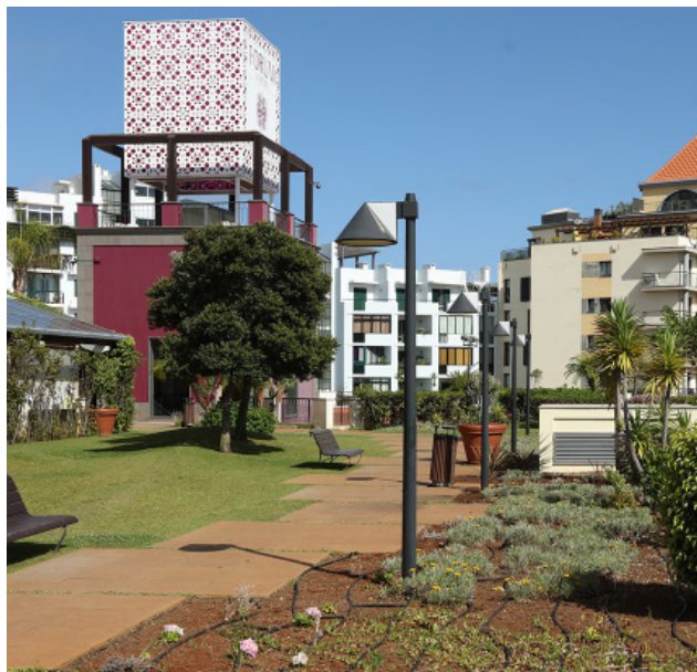
Fig.34- Jardim na cobertura Forum Madeira
