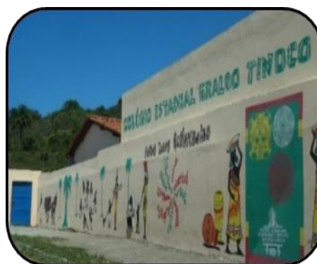
Figura 40 – muro na lateral da escola Rosania Amorim
