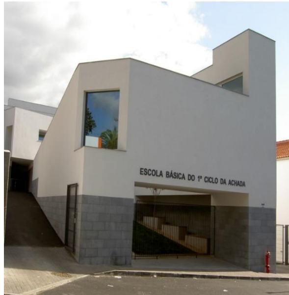
Figura 40 | Escola da Achada, Funchal
