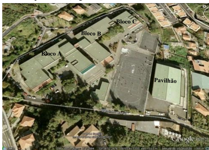
Figura 1 - Instalações da EBSGZ (Fotografia retirada do Google Earth, no dia 19-11-2014).
