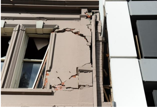
Figura 12 - Colisão de edifícios adjacentes durante o sismo de 1985, Mexico [4]
