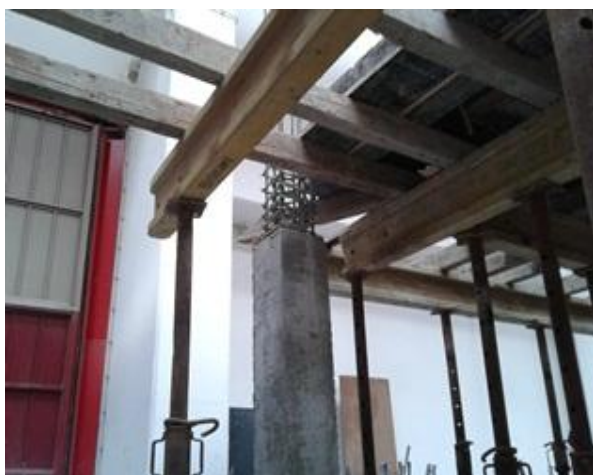
Figura 23 - Pormenor do processo de construção dos pilares
