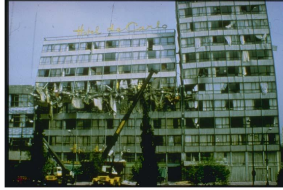
Figura 13 - Danos causados pela colisão de edifícios adjacentes [11]
