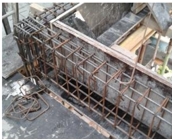
Figura 24 - Pormenor do processo de construção das vigas
