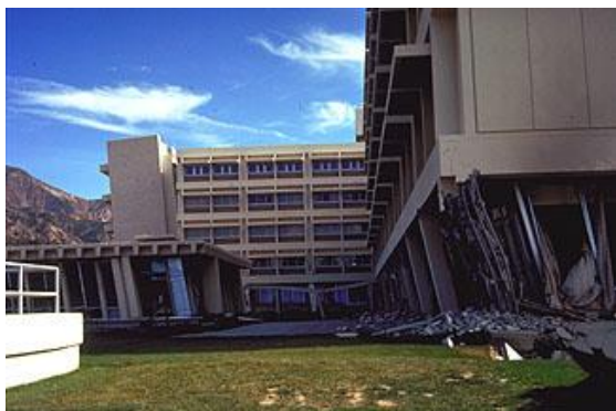
Figura 10 – “Soft storey” no recém construído Olive View Hospital durante o sismo de San Fernando, California [4]
