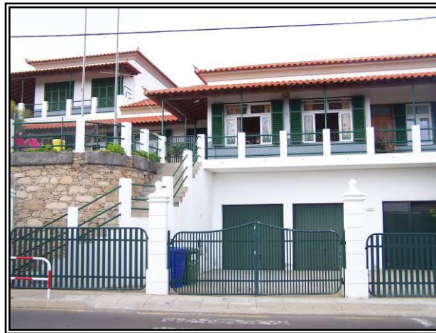
Figura 2 - Edifício da Escola
