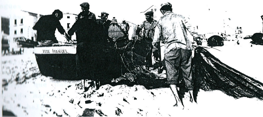
Fig. 64 - VERIFICATION DU FILET AVANT LA SECONDE CALEE -
