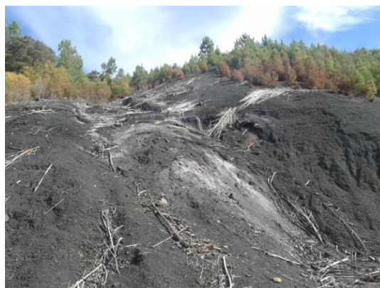
Figura A.3 – Visão geral da área B em autocombustão.
