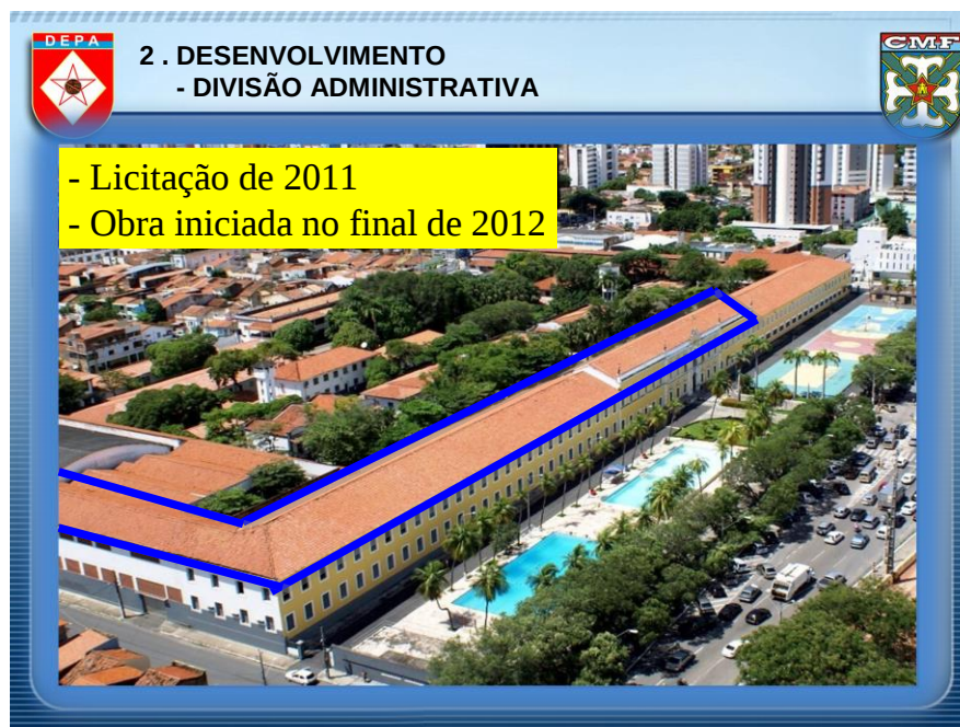
(Figura 03- Slide 31 da apresentação do Cmt do CMF ao Diretor da DEPA – Retelhamento do CMF).
