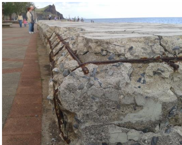
Figura 76: Muro da promenade dos Reis Magos
