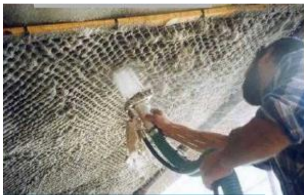
Figura 10: Aplicação do eletrólito sobre a malha metálica, extraído de [36].
