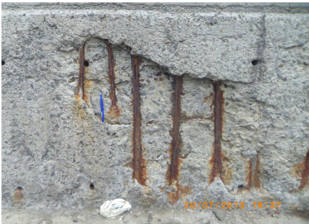
Figura 67: Muro de proteção do cais do Porto Novo
