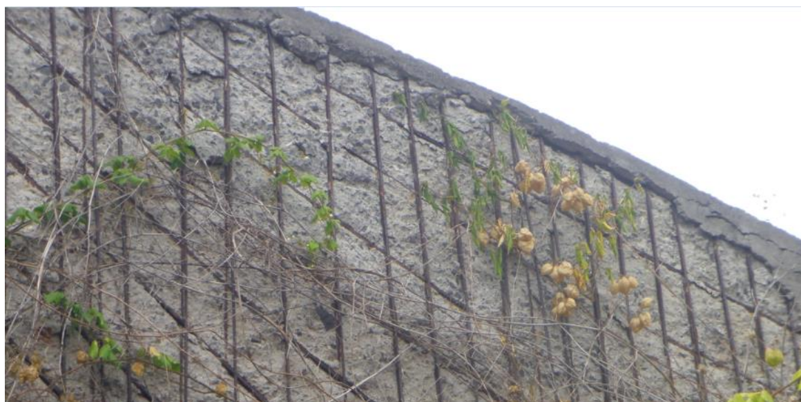
Figura 103: Espessura de recobrimento do emboquilhamento do túnel da Nazaré.
