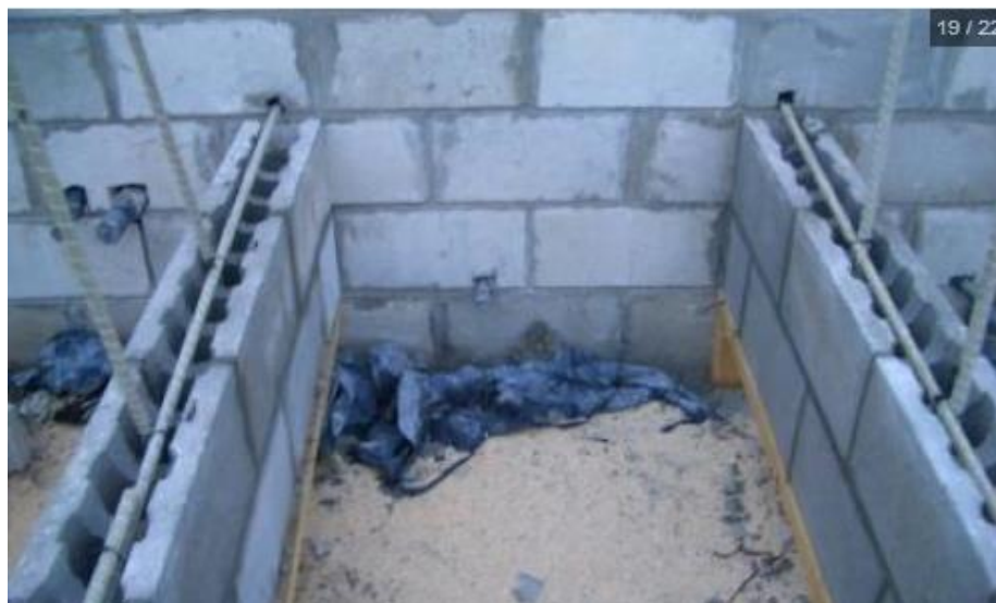
Figura 58: Reforço de alvenarias estruturais com varões GFRP.
