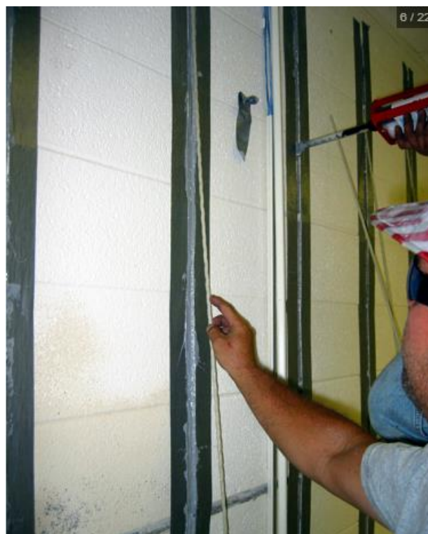
Figura 56: Colocação dos varões de GFRP no rasgo.
