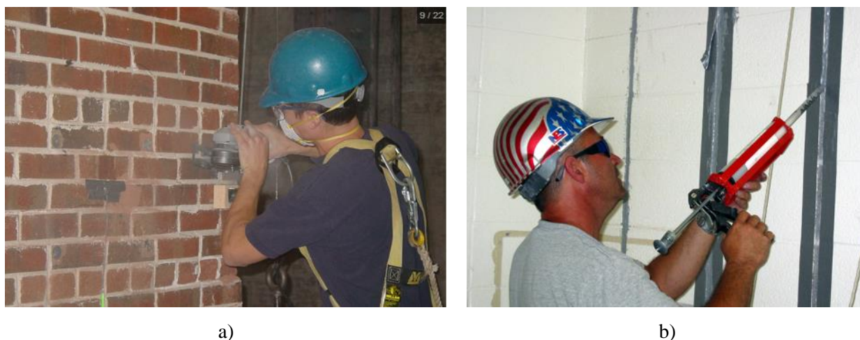
Figura 55: a) Abertura de rasgo em parede de alvenaria de tijolo cerâmico; b) Colocação de silicone no rasgo (extraído de HB).
