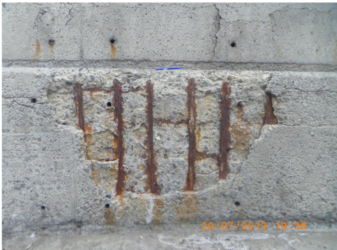
Figura 66: Muro de proteção do cais do Porto Novo
