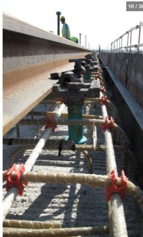
Figura 47: Construção de linha ferroviária em Miami, extraído de www.aslanfrp.com .
