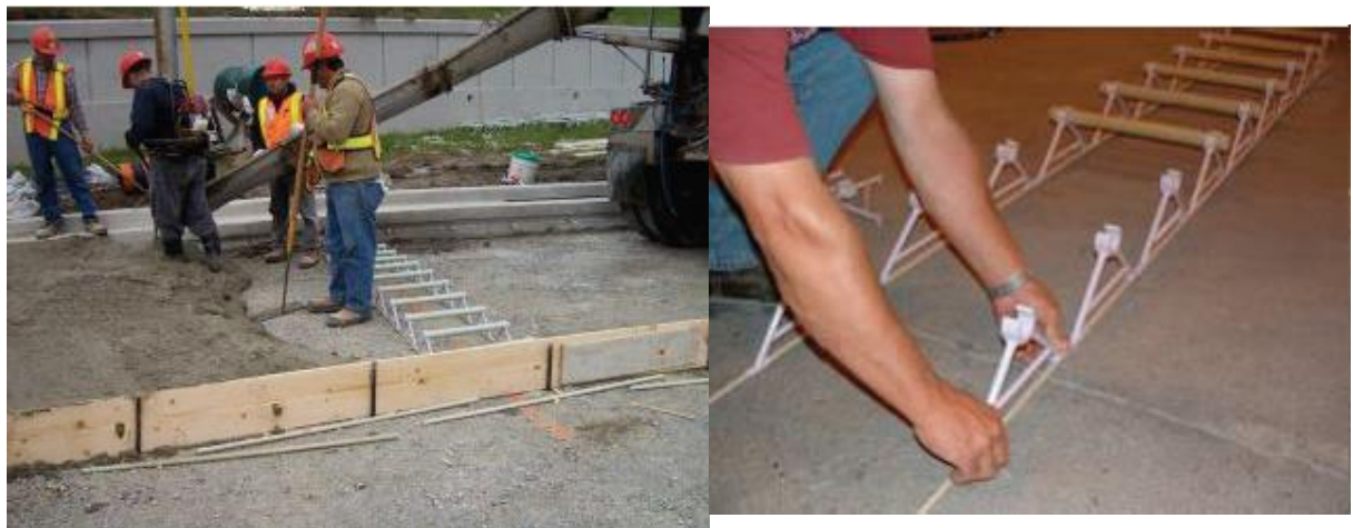
Figura 48: Aplicação dos "GFRP Dowel Bars", extraído de [21].
