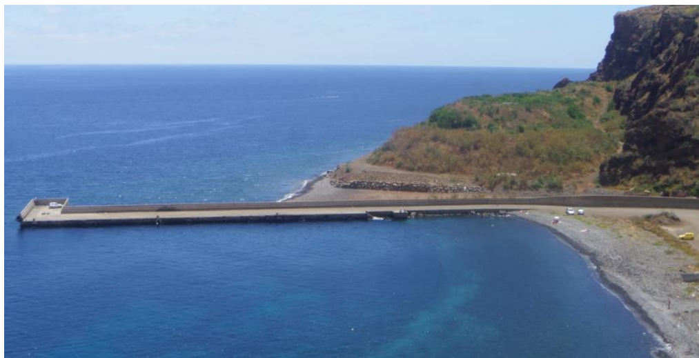
Figura 65: Cais de acostagem do Porto Novo.
