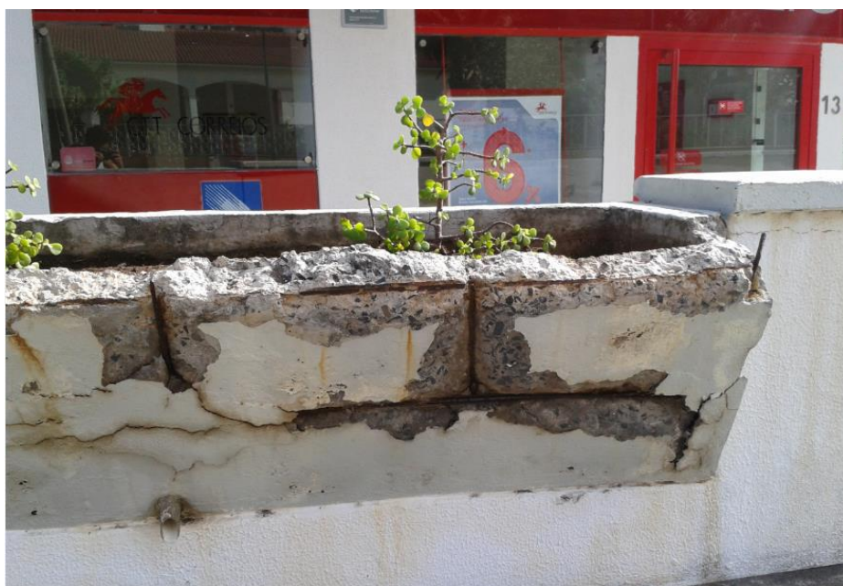
Figura 94: Canteiro na estação de correios do Porto Moniz.
