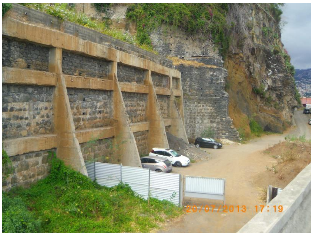
Figura 79: Contrafortes no Funchal.
