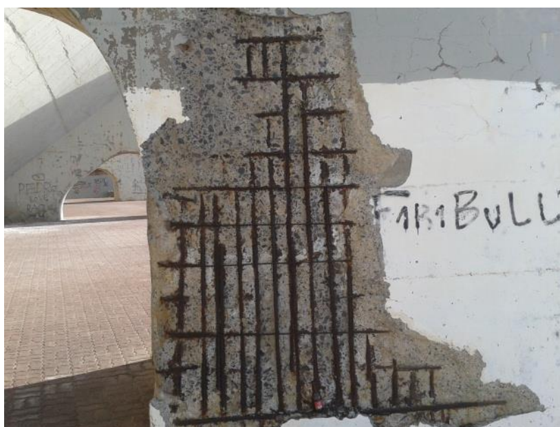
Figura 69: Lado oeste da estrutura.
