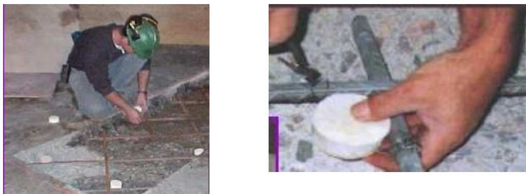
Figura 13: Colocação dos ânodos sacrificiais
