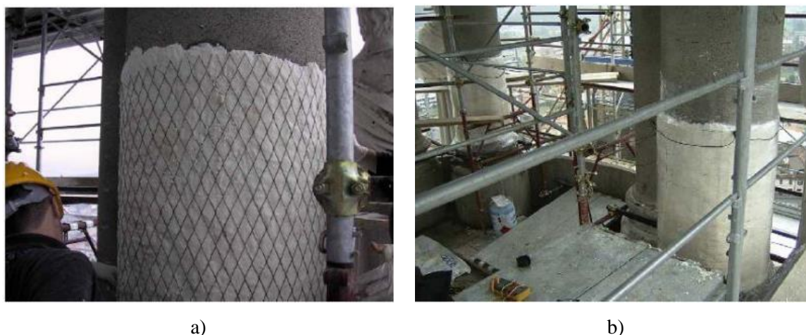
Figura 8: Exemplo de aplicação num pilar: a) colocação da malha (ânodo) sobre uma 1ªcamada de fibra de celulose embebida em solução \text{Na}_2\text{CO}_3 e b) colocação de nova camada de fibra de celulose sobre a malha e selagem com plástico, retirado de [32].
