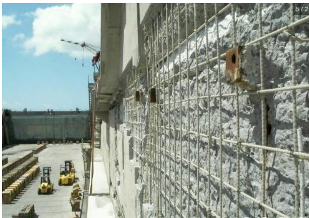
Figura 54: Substituição das armaduras de aço por armaduras de GFRP
