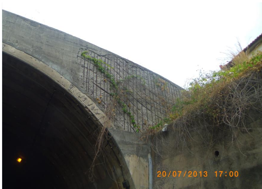
Figura 102: Emboquilhamento do túnel da Nazaré.
