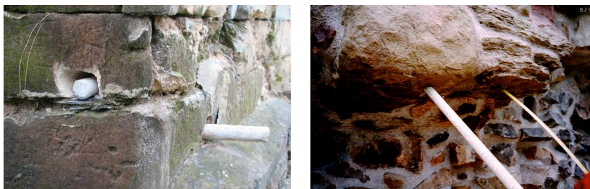
Figura 59: Reforço de paredes em pedra com varões GFRP.
