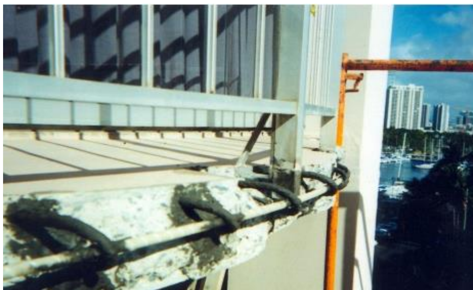
Figura 53: Reabilitação de varanda (retirado de aslanfrp.com)
