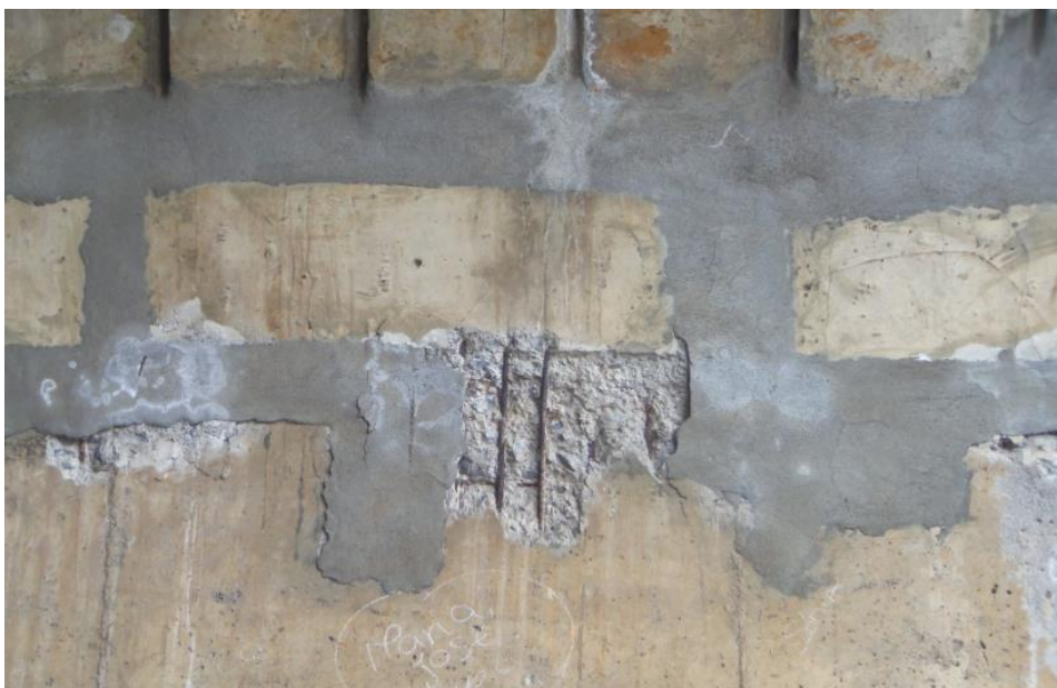
Figura 106: Intervenção no interior do túnel da Nazaré.
