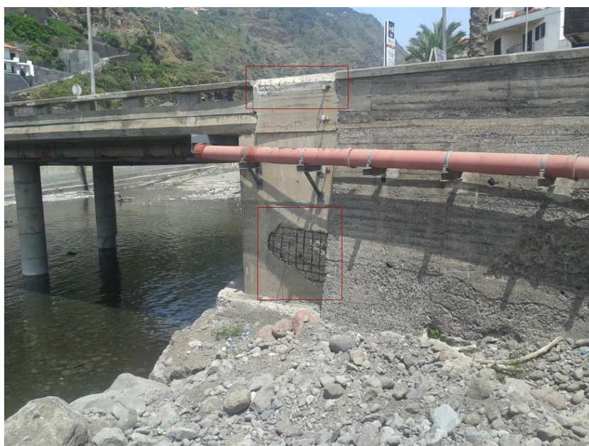
Figura 97: Estado geral da estrutura.
