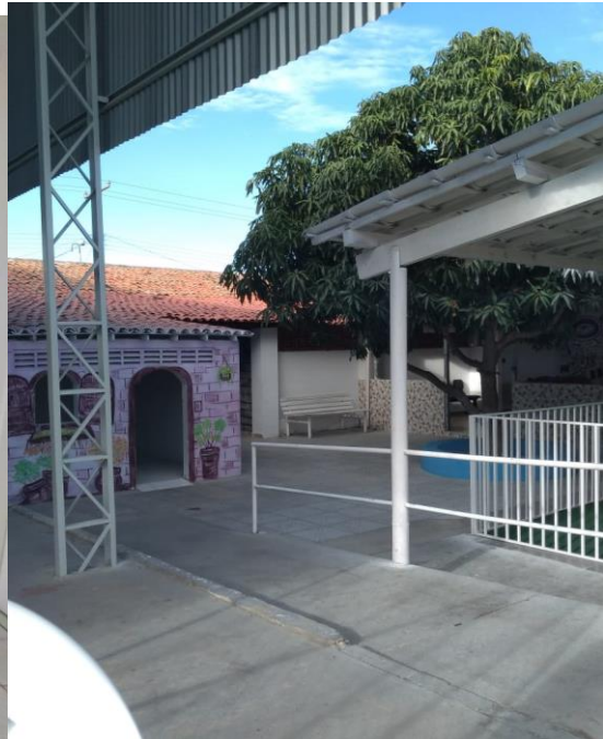
Imagem 8 -Área externa (Fonte: a própria autora)
