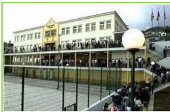
Figura 24. EB1/PE de São Roque - Edifício do Galeão
