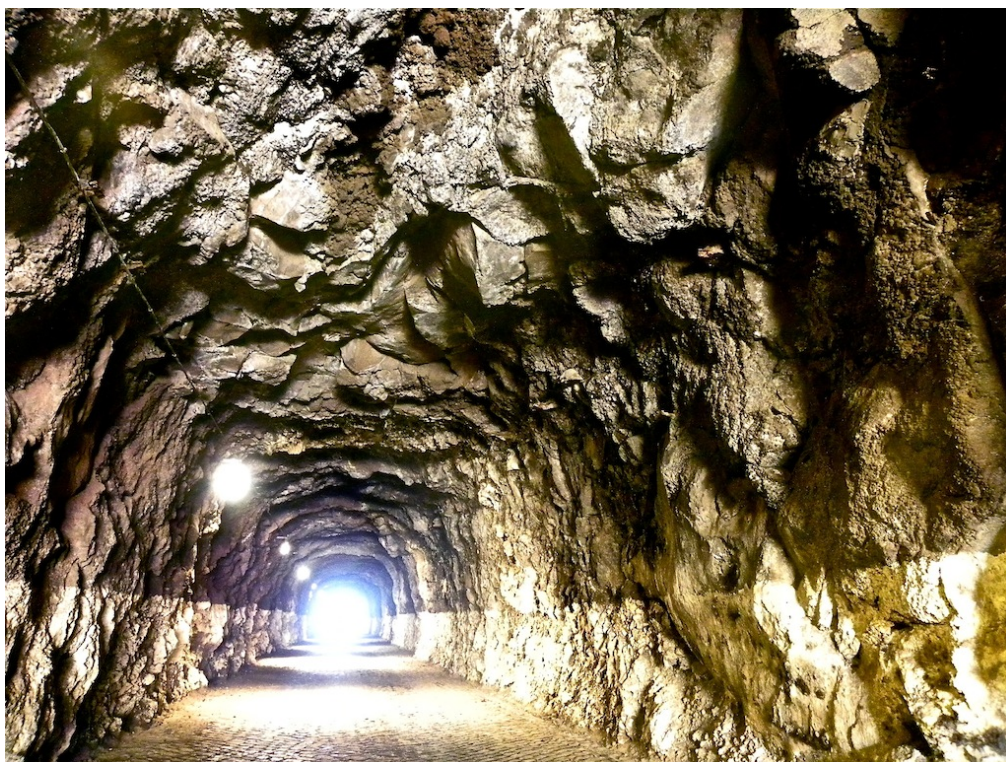
Vista para o emboquilhamento sudeste
