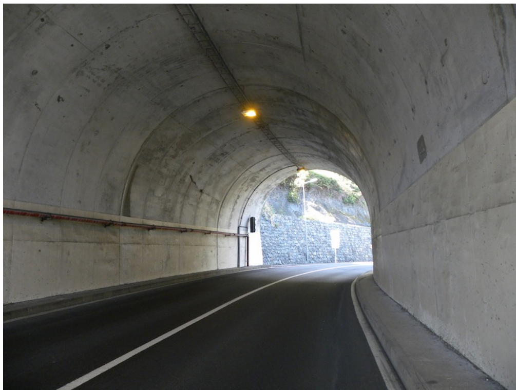
Vista para o emboquilhamento sudoeste
