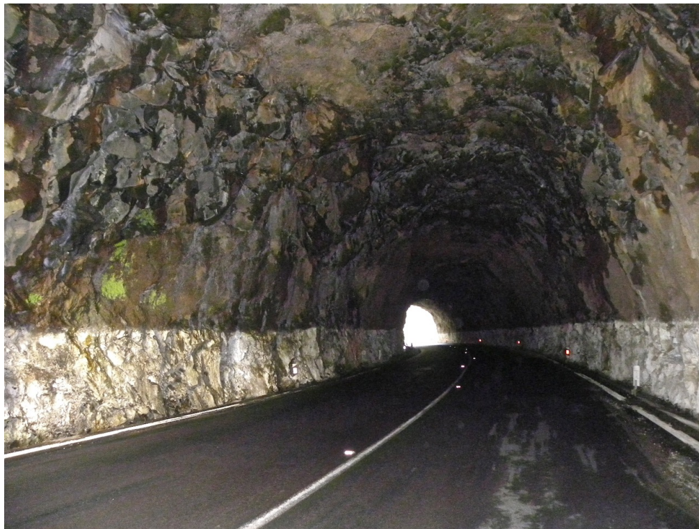
Vista para o emboquilhamento nordeste
