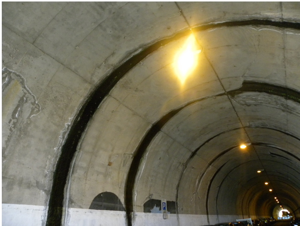
Vista para o emboquilhamento este
