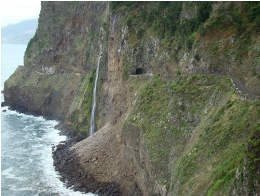
Figura 32 – Vista para este antes da derrocada de 2008 (RAMEDM, s.d.)
