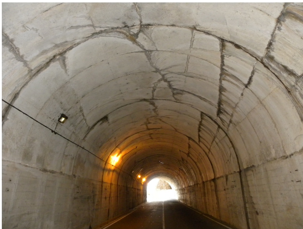
Vista para o emboquilhamento sudoeste
