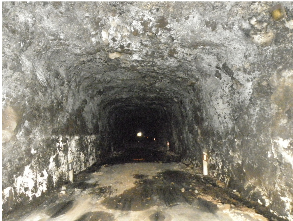
Vista para o emboquilhamento norte
