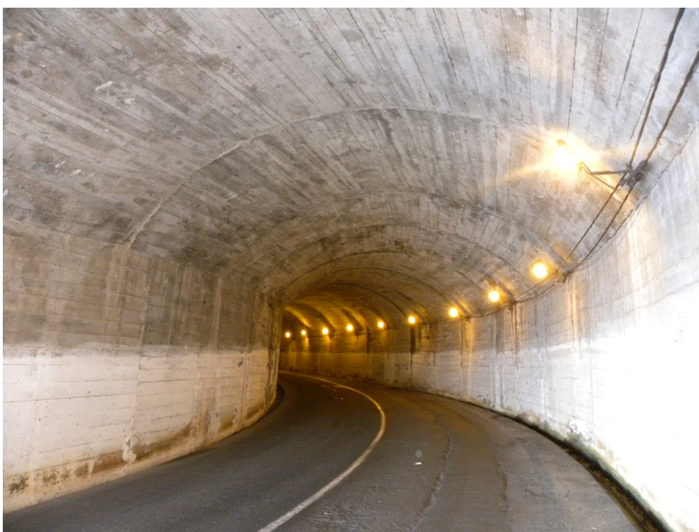
Vista para o emboquilhamento norte
