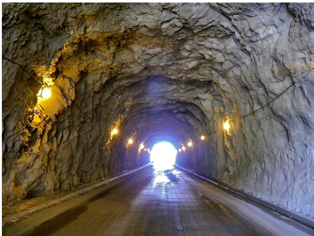
Vista para o emboquilhamento oeste
