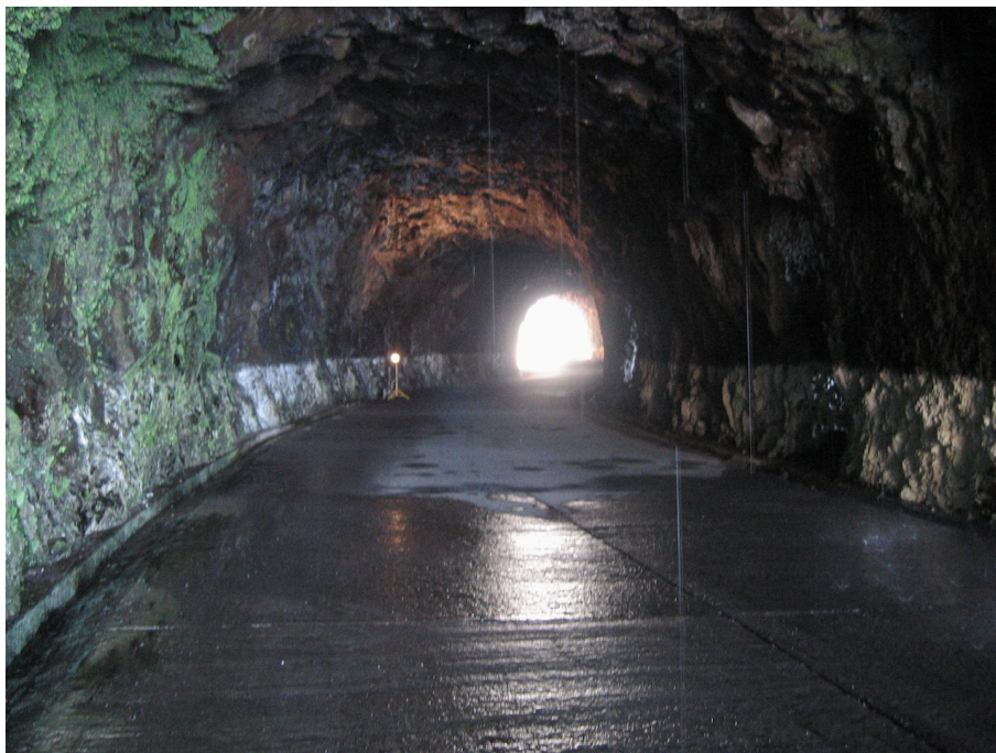
Figura 35 – Secção corrente (vista para oeste) – Túnel Véu da Noiva (RAMEDM, s.d.)
