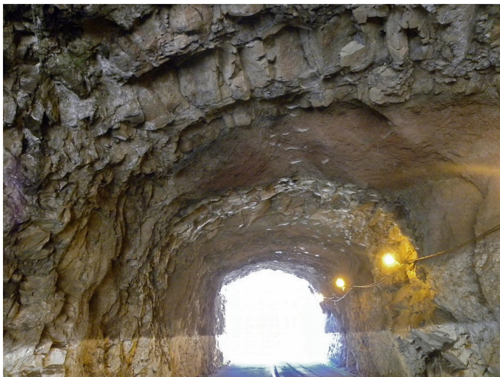
Vista para o emboquilhamento norte
