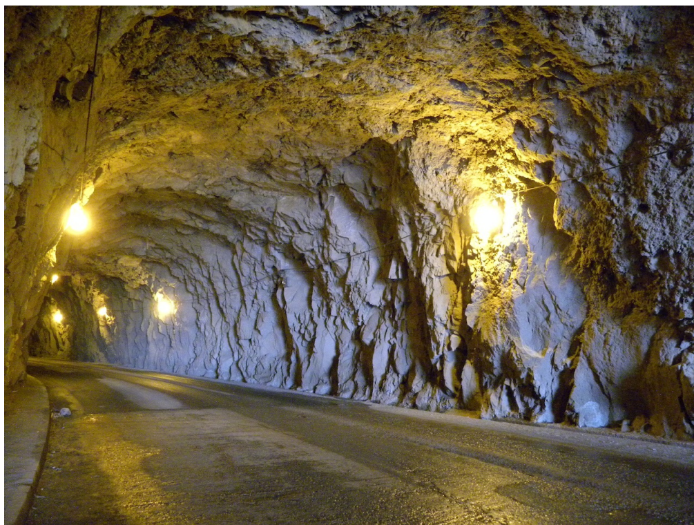
Vista para o emboquilhamento oeste
