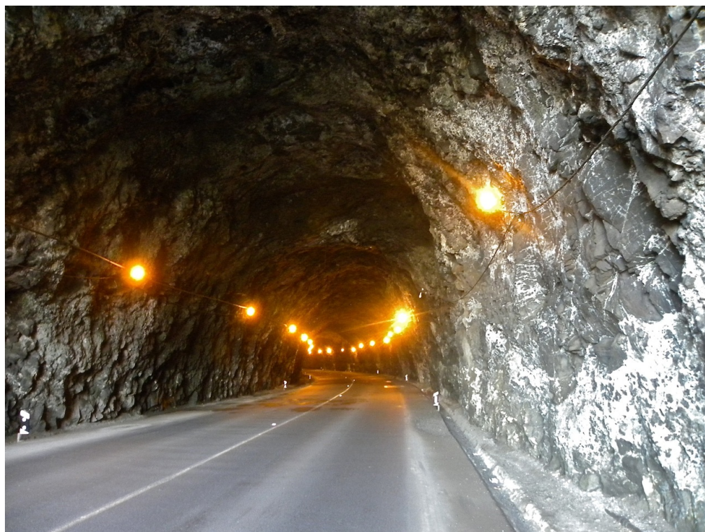
Vista para o emboquilhamento nordeste
