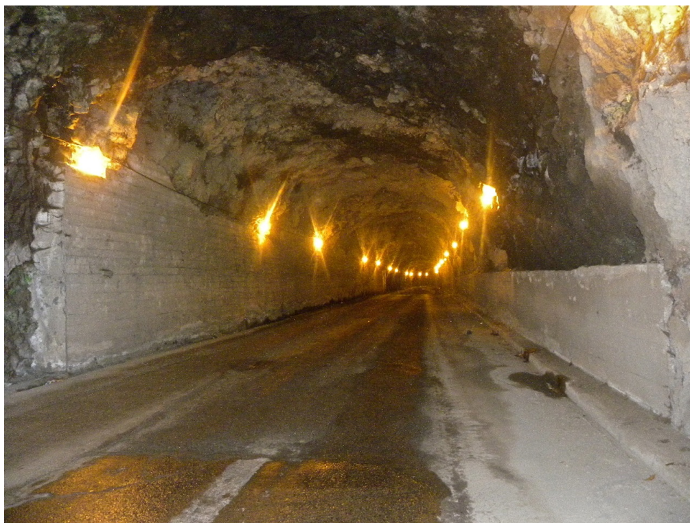
Junto ao emboquilhamento oeste
