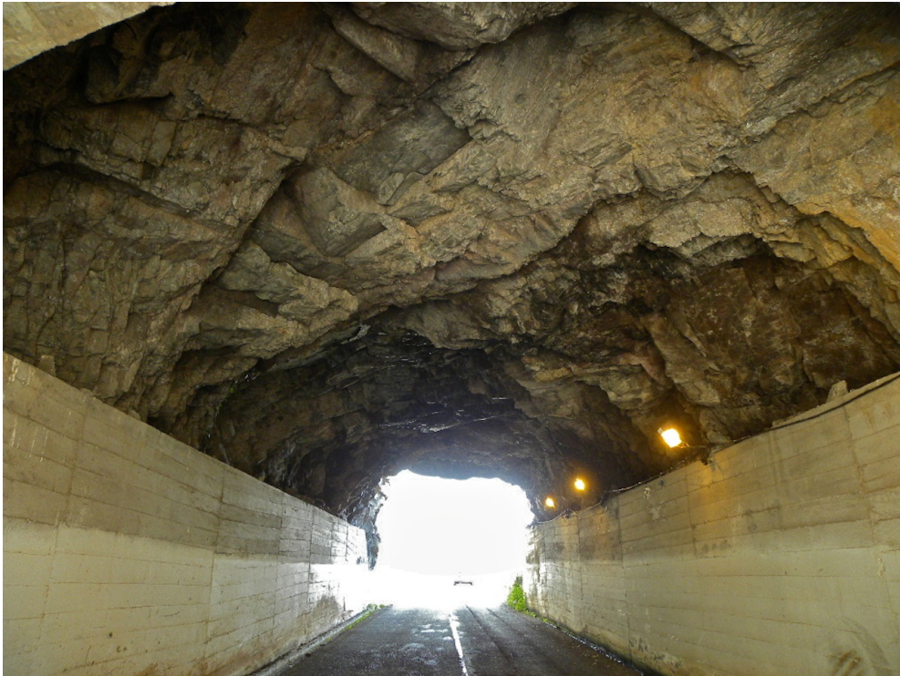
Vista para o emboquilhamento sudeste
