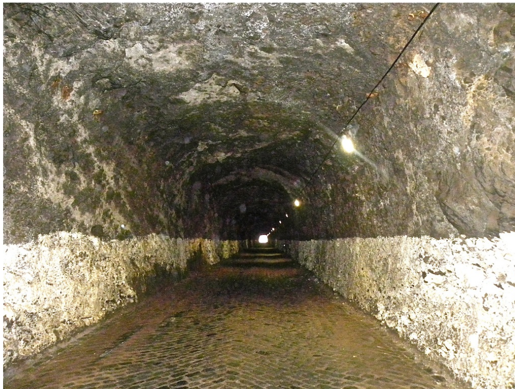
Vista para o emboquilhamento noroeste
