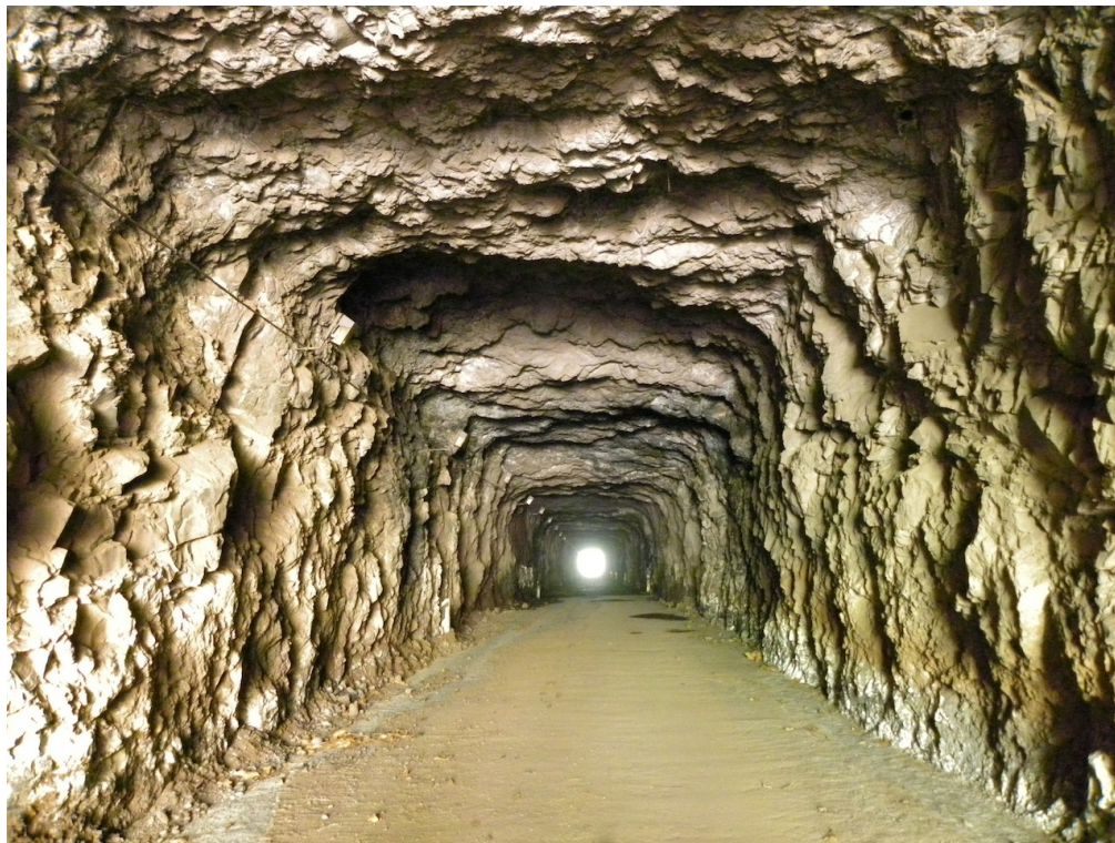
Vista para o emboquilhamento norte
