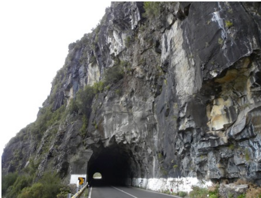
Figura 49 – Emboquilhamento nordeste Paul da Serra - Túnel I, 1990
