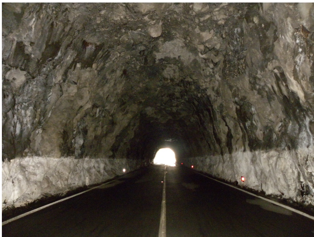
Vista para o emboquilhamento oeste
