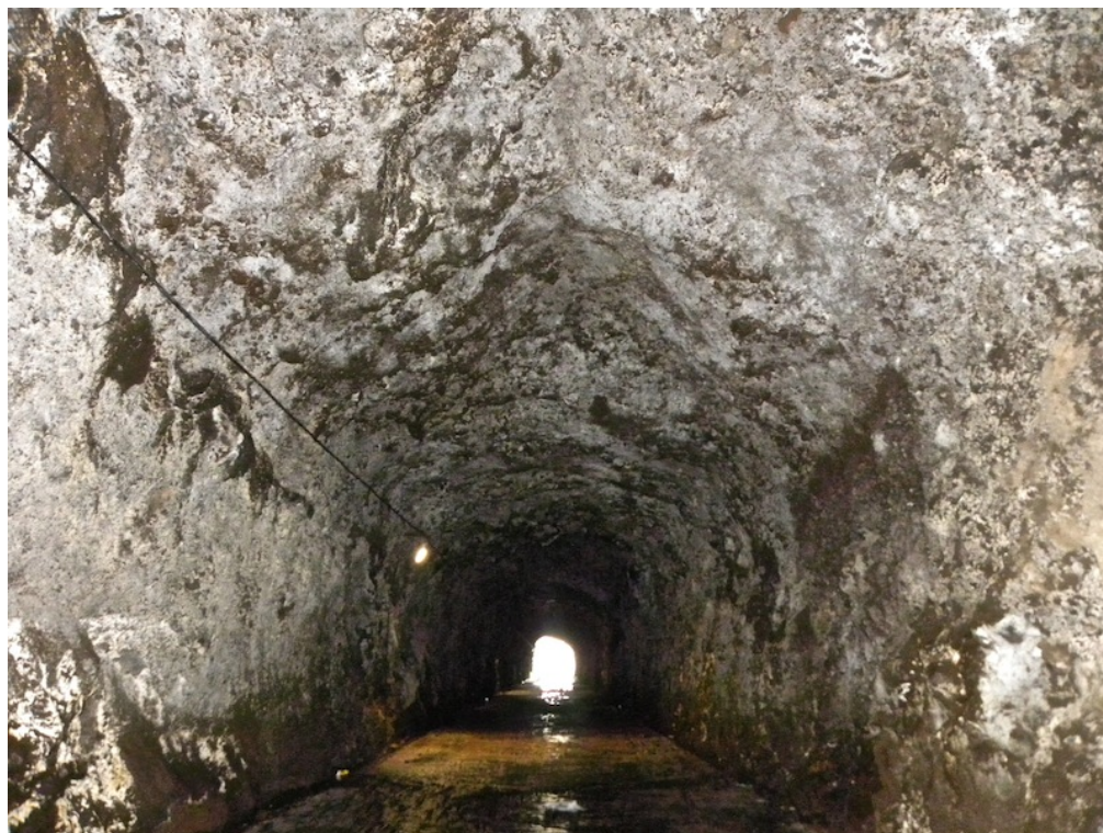
Vista para o emboquilhamento noroeste
