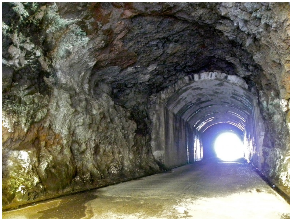
Vista para o emboquilhamento oeste
