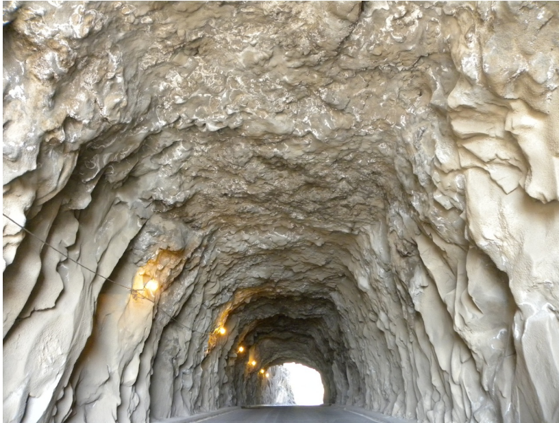
Figura 10 – Revestimento com betão projetado na secção corrente - Túnel dos Anjos, 1965
