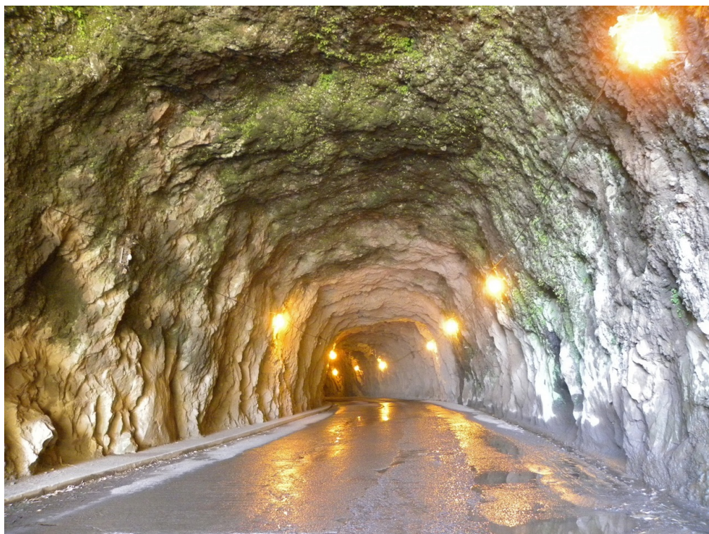
Junto ao emboquilhamento sul
