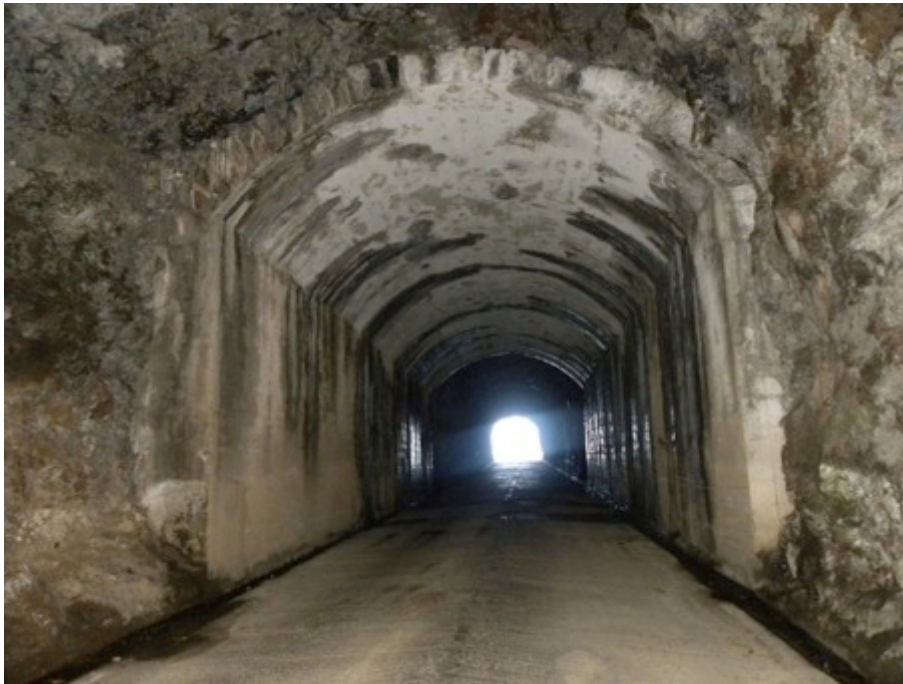
Figura 5 – Exemplo de revestimento em betão ciclópico - Túnel Água D'Alto, 1965
