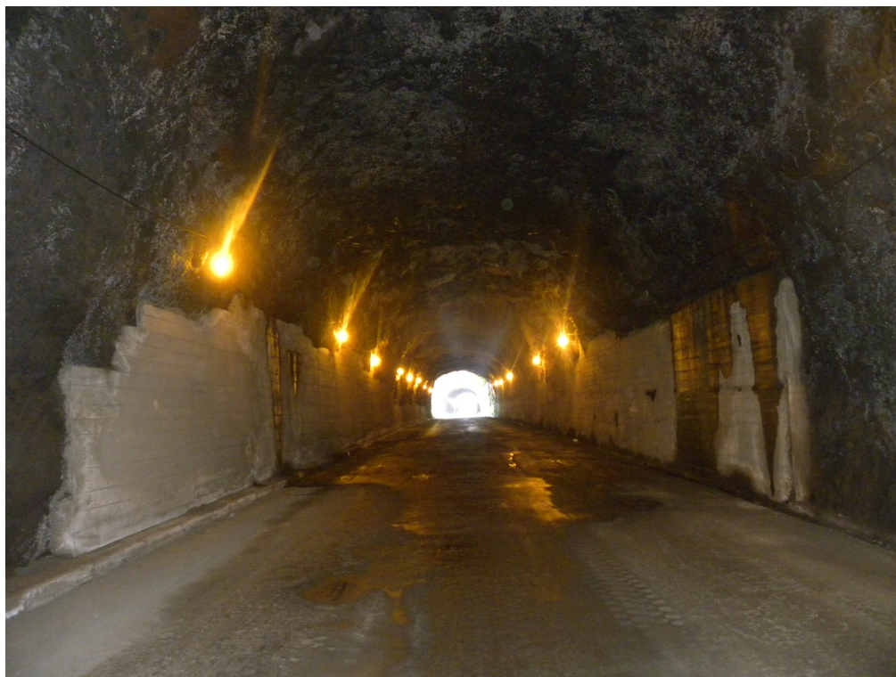
Junto ao emboquilhamento oeste
