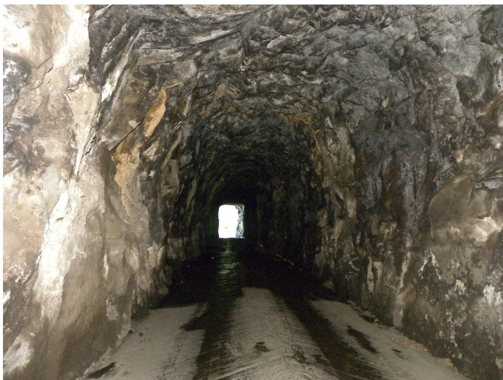
Vista para o emboquilhamento este
