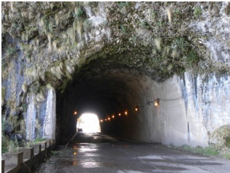
Figura 9 – Enchimentos nos hasteais emboquilhamento este do Túnel da Madalena do Mar, 1968
