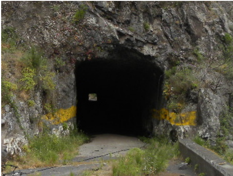
Figura 3 – Exemplo de secção retangular - Túnel II do Grupo do Curral das Freiras, 1959
