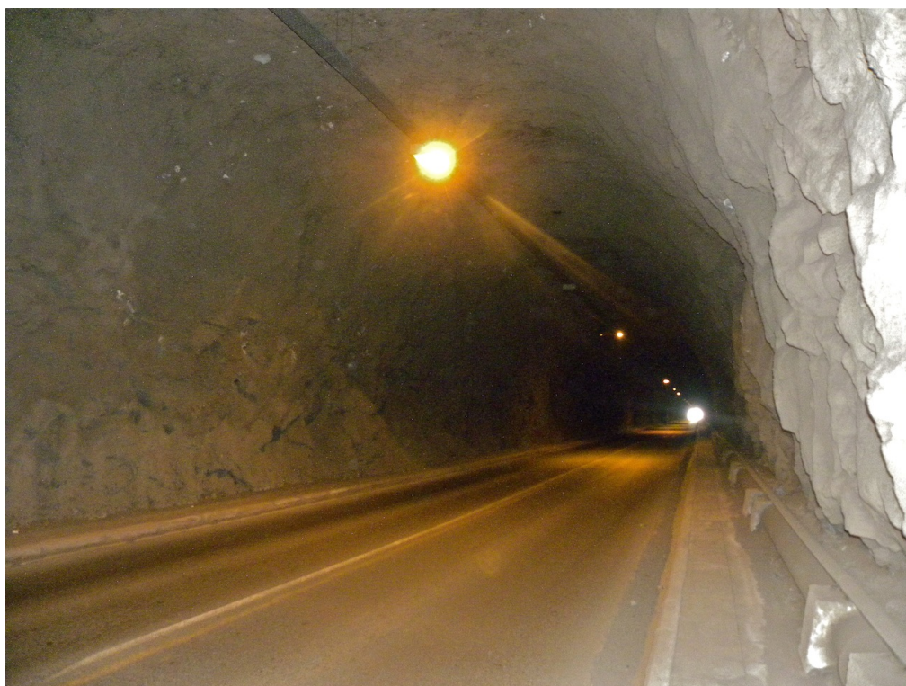
Vista para o emboquilhamento sudoeste
