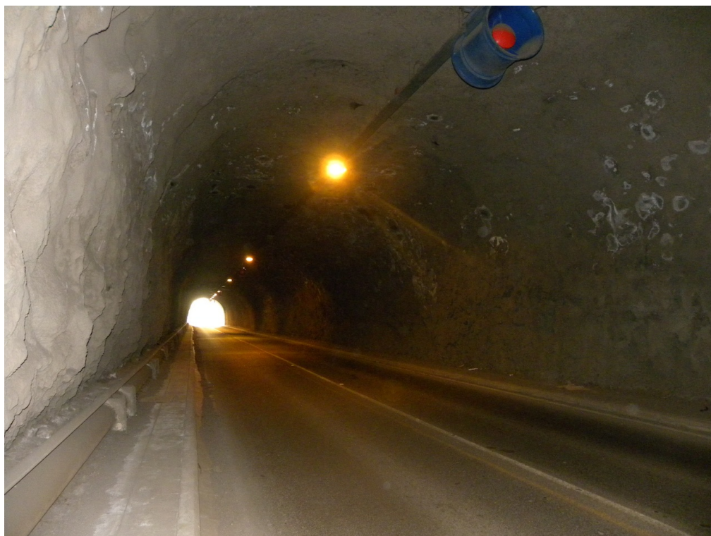
Vista para o emboquilhamento nordeste
