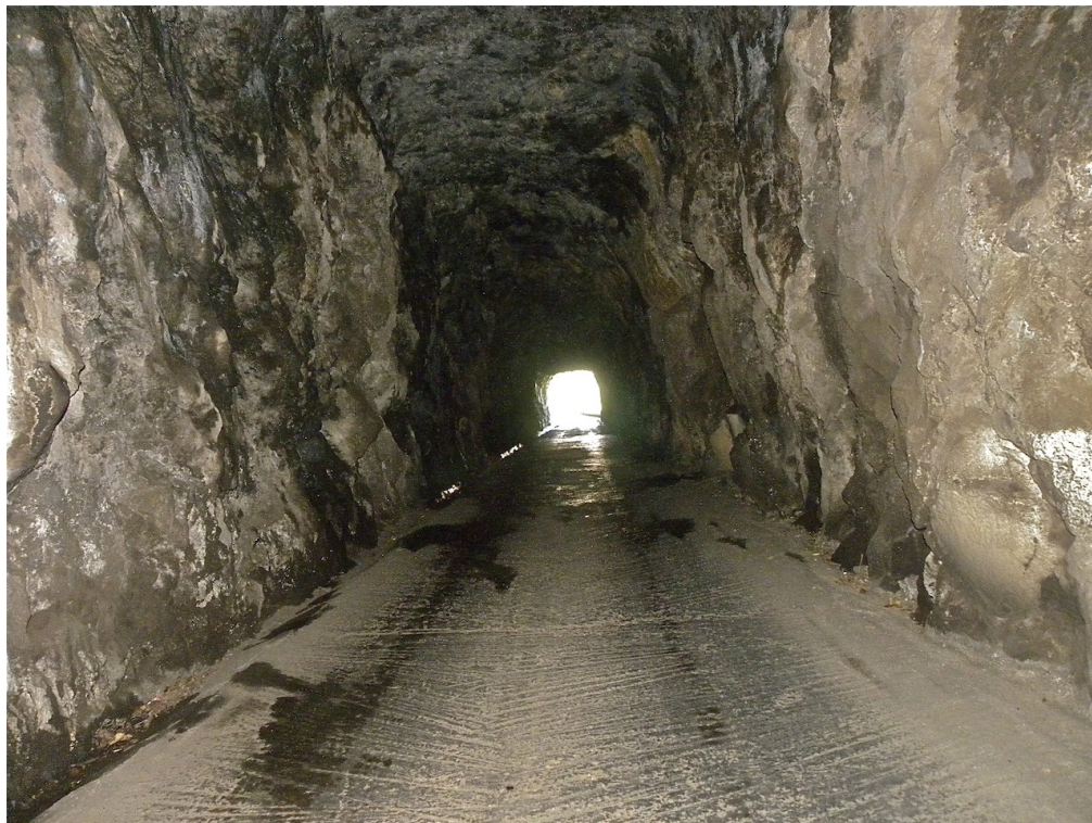
Vista para o emboquilhamento oeste
