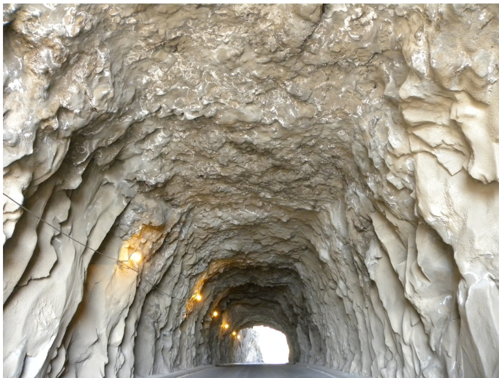
Vista para o emboquilhamento este
