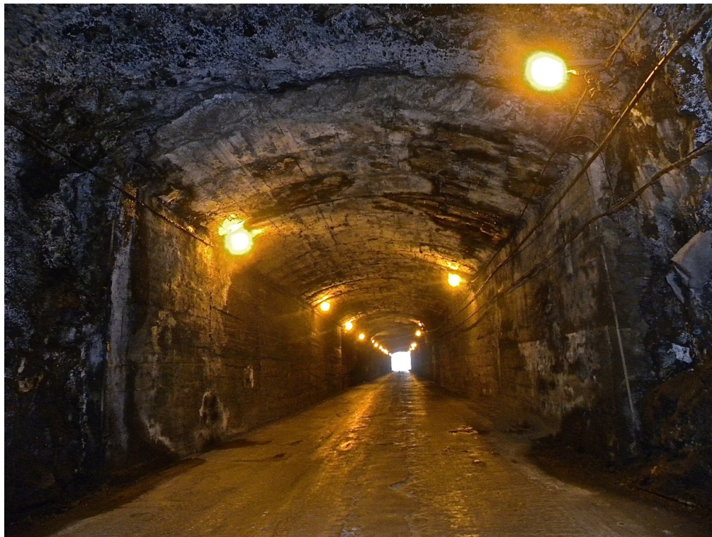
Vista para o emboquilhamento sudoeste
