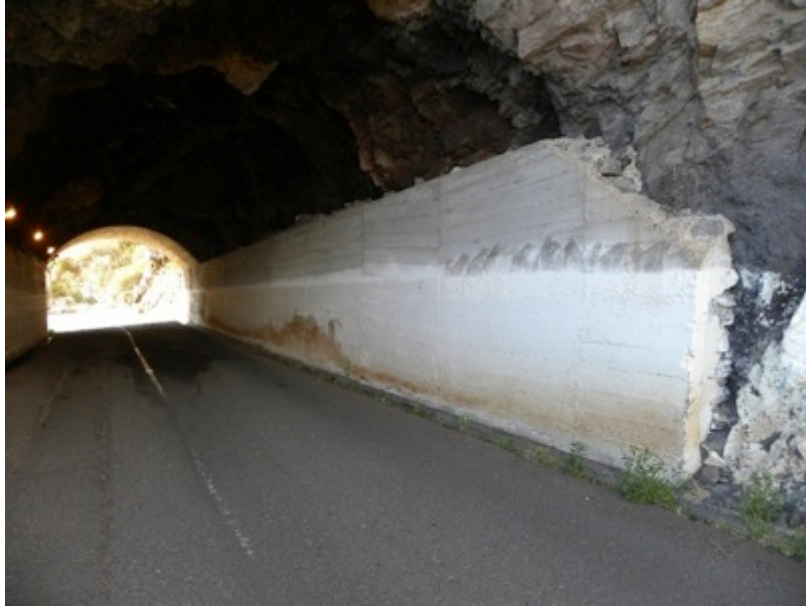
Figura 8 – Enchimentos nos hasteais do Túnel III do Grupo do Paul do Mar, 1971
