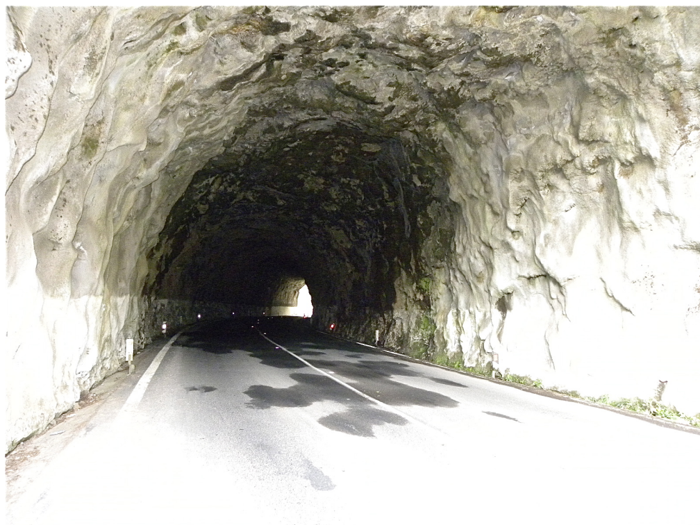
Vista para o emboquilhamento Sudoeste
