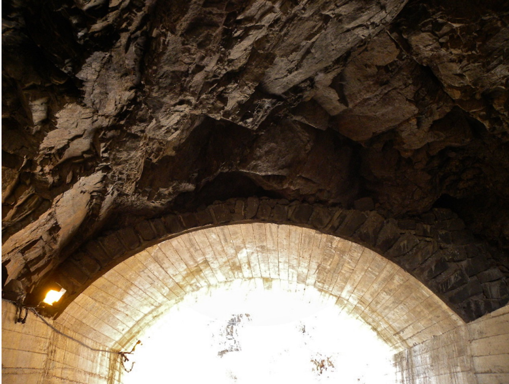
Vista para o emboquilhamento noroeste
