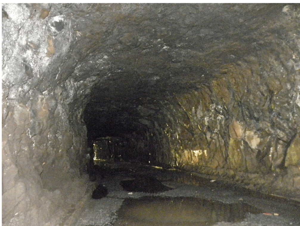
Vista para o emboquilhamento oeste
