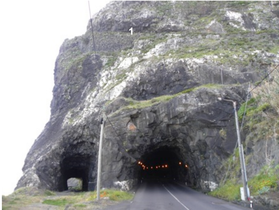
Figura 28 – Emboquilhamento oeste do túnel Fajã da Areia e o Caminho Real (1)
