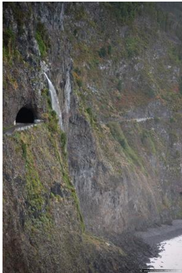
Figura 31 – Emboquilhamento este do Túnel Vêu da Noiva (foto de Hugo Reis, 2005)
