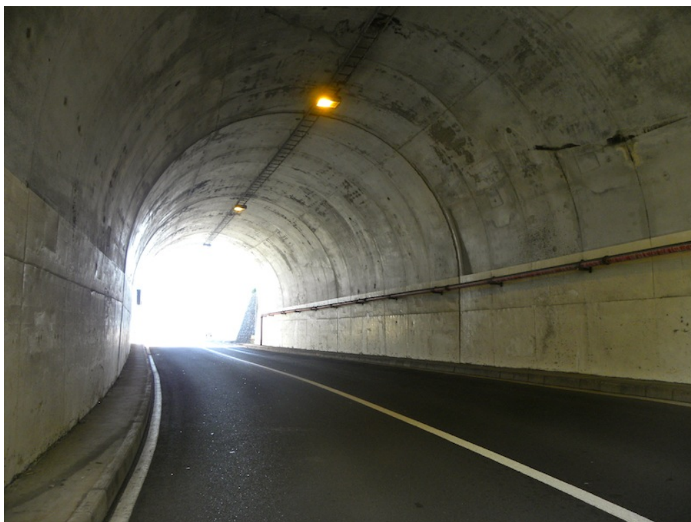
Vista para o emboquilhamento nordeste
