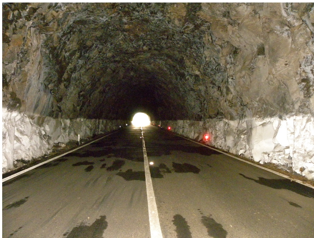
Vista para o emboquilhamento sudoeste
