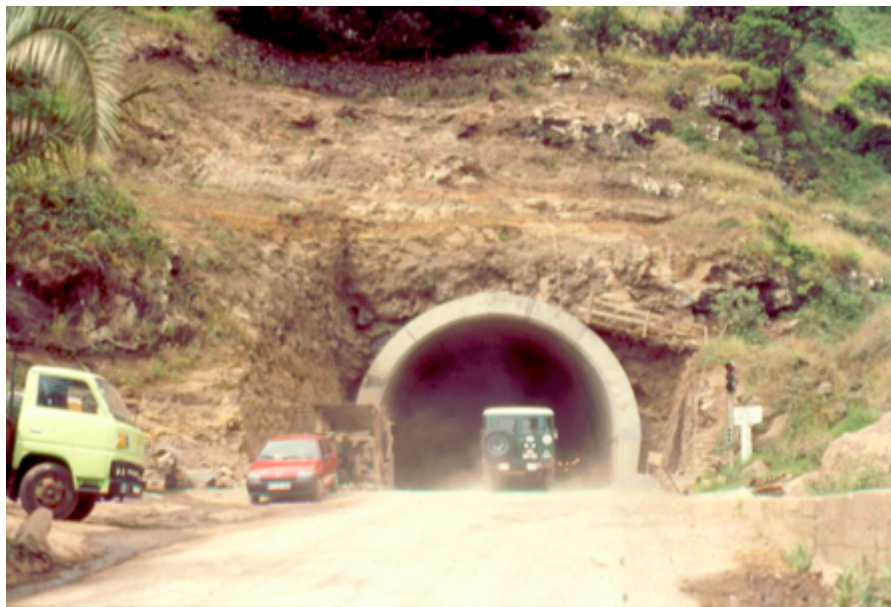
Figura 19 – Emboquilhamento nordeste após alargamento (Cenor, 1992)
