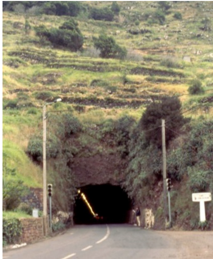
Figura 20 – Emboquilhamento sudoeste antes do alargamento (Cenor, 1991)
