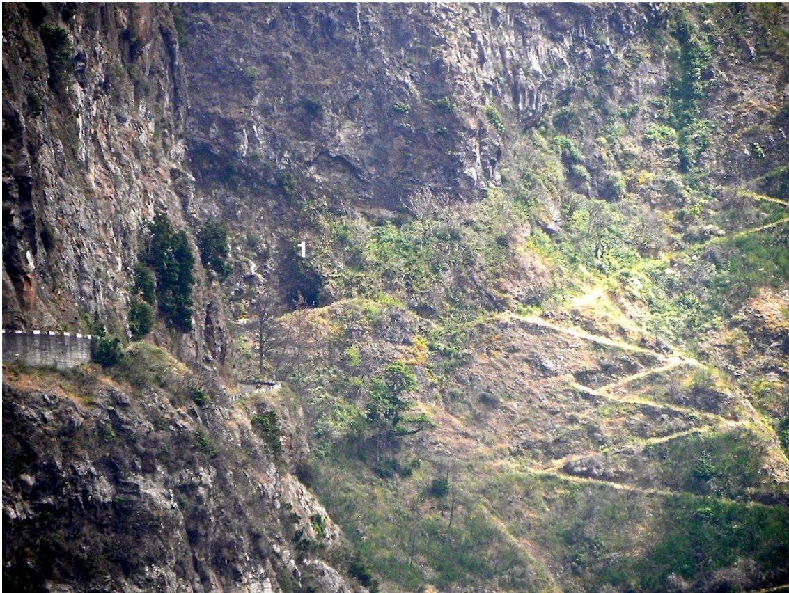
Figura 47 – Antigos acessos ao Curral das Freiras – Túnel I (1), 1959
