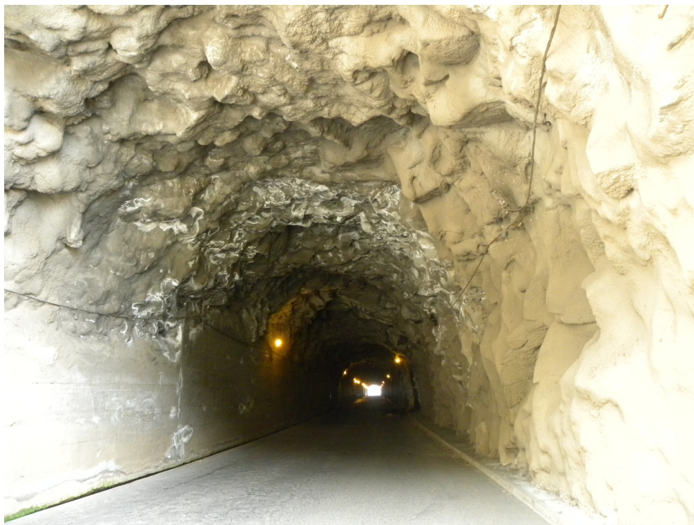
Vista para o emboquilhamento sudeste
