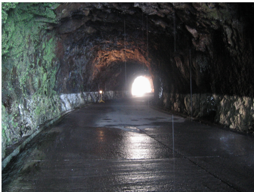
Vista para o emboquilhamento oeste
