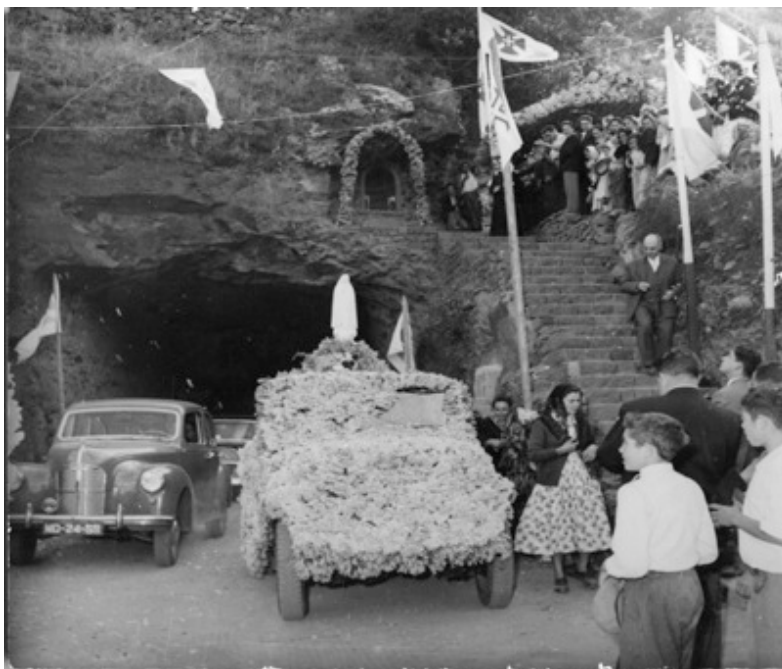
Figura 15 – Inauguração do túnel do Caniçal – Emboquilhamento este
