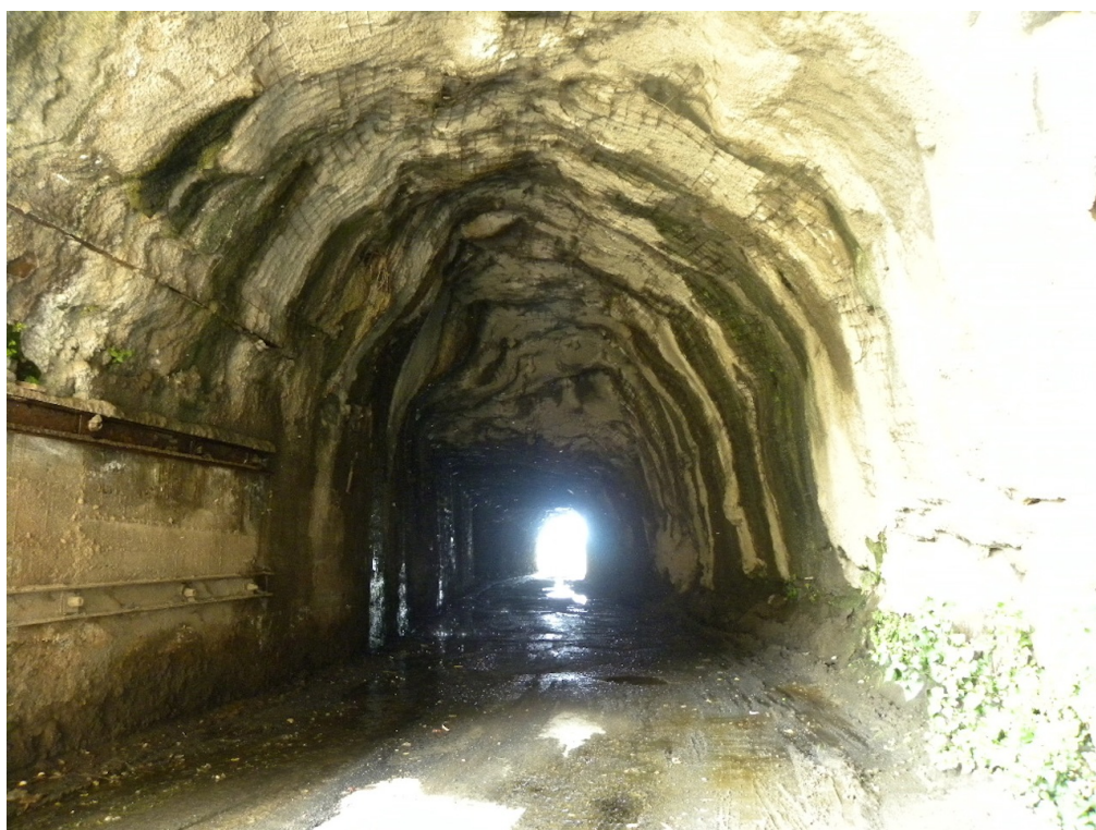
Vista para o emboquilhamento sudoeste
