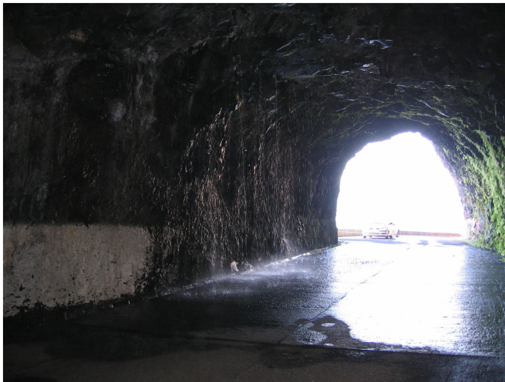
Vista para o emboquilhamento este
