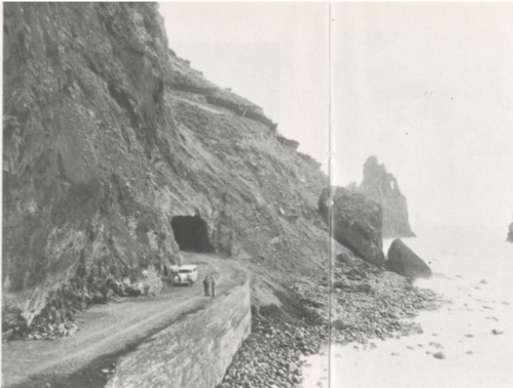
Figura 27 – Junto ao emboquilhamento este do túnel Ribeira da Janela, anos 40 a 50 (Simões, Sumares e Silva 1983).
