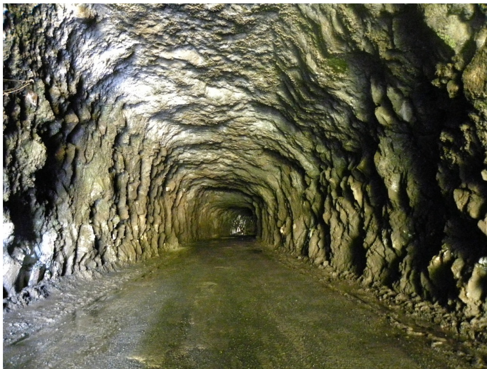
Vista para o emboquilhamento este
