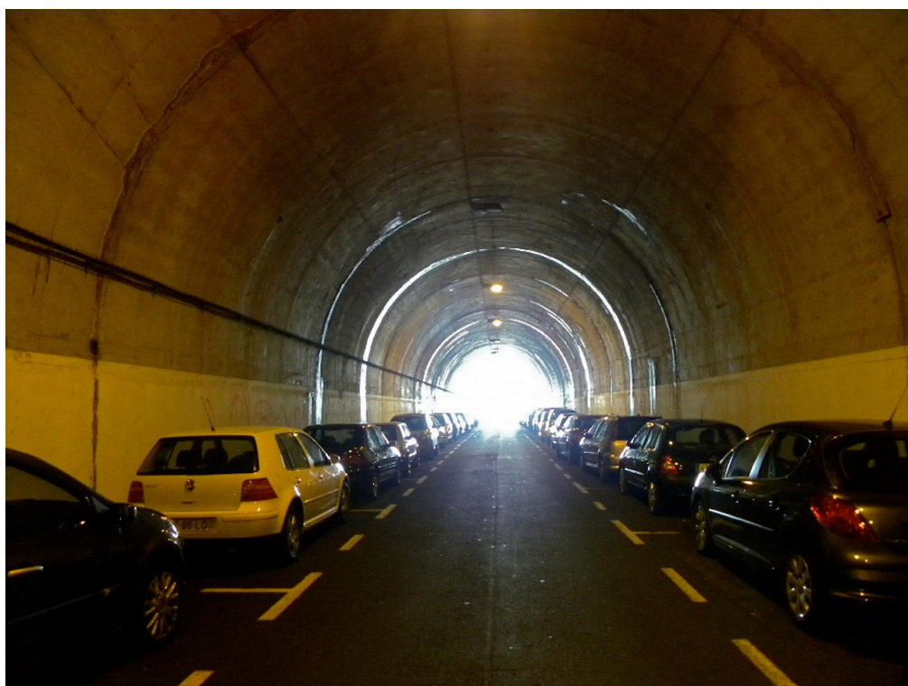
Vista para o emboquilhamento oeste
