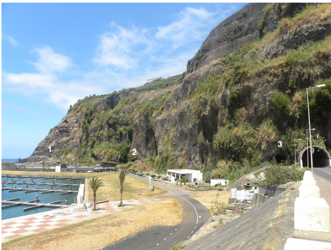
Figura 38 –Túneis grupo sul junto ao Lugar de Baixo
