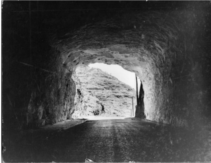
Figura 14 – Secção corrente inicial do túnel do Caniçal, 1955
