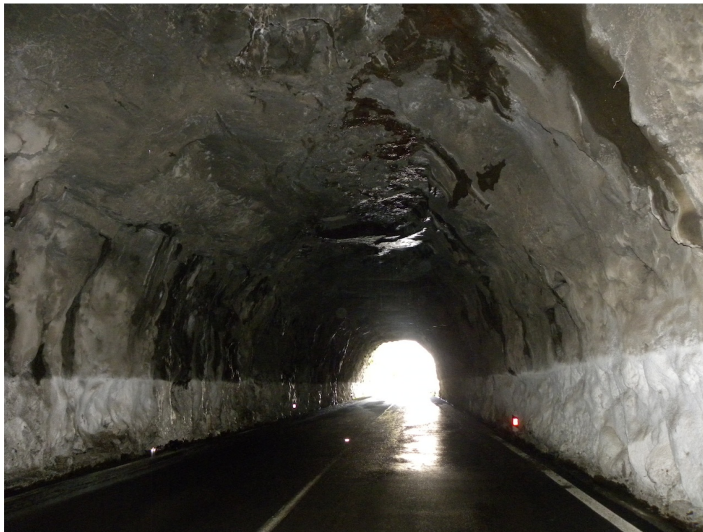
Vista para o emboquilhamento este
