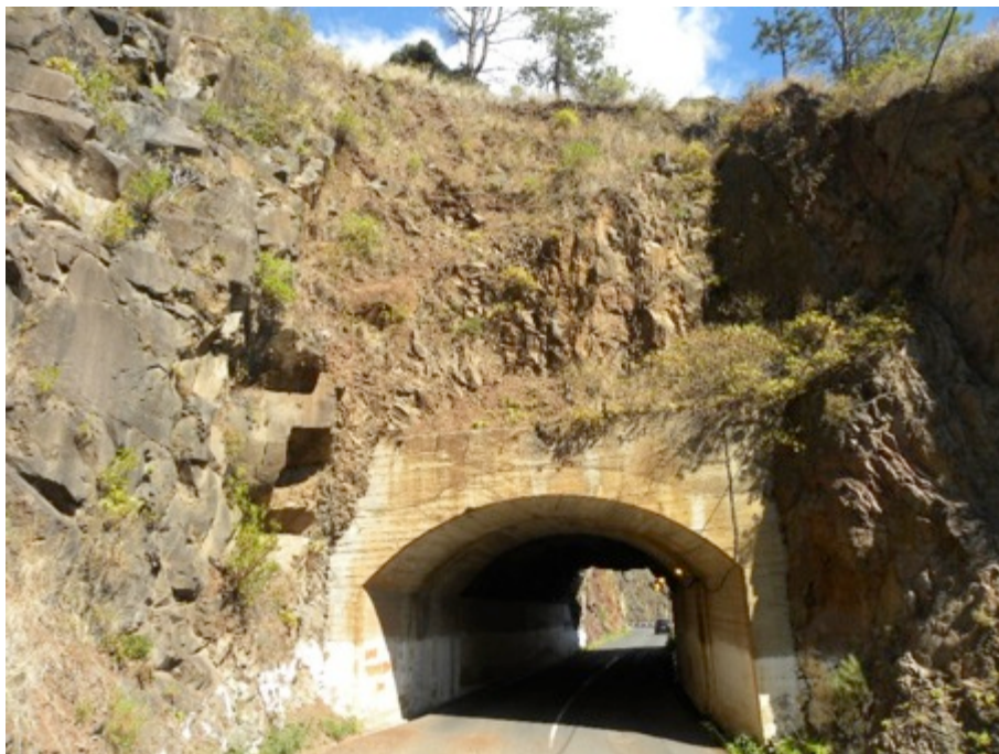
Figura 45 – Revestimento no emboquilhamento do Túnel III
