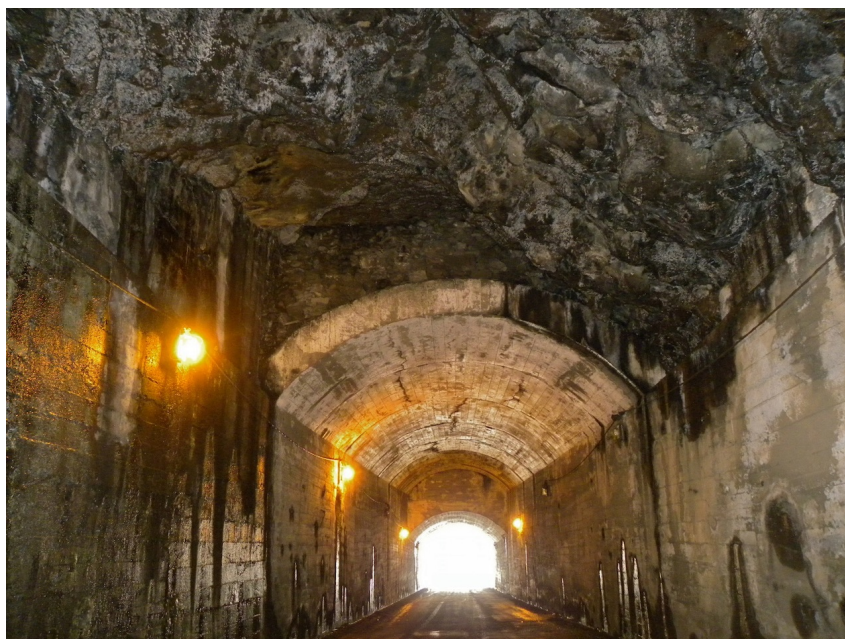
Vista para o emboquilhamento sudeste
