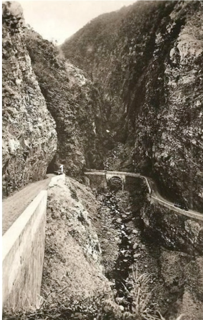
Figura 25 – Túnel da Ribeira do Inferno (1) (foto cedida por Élvio Caires, s.d.)
