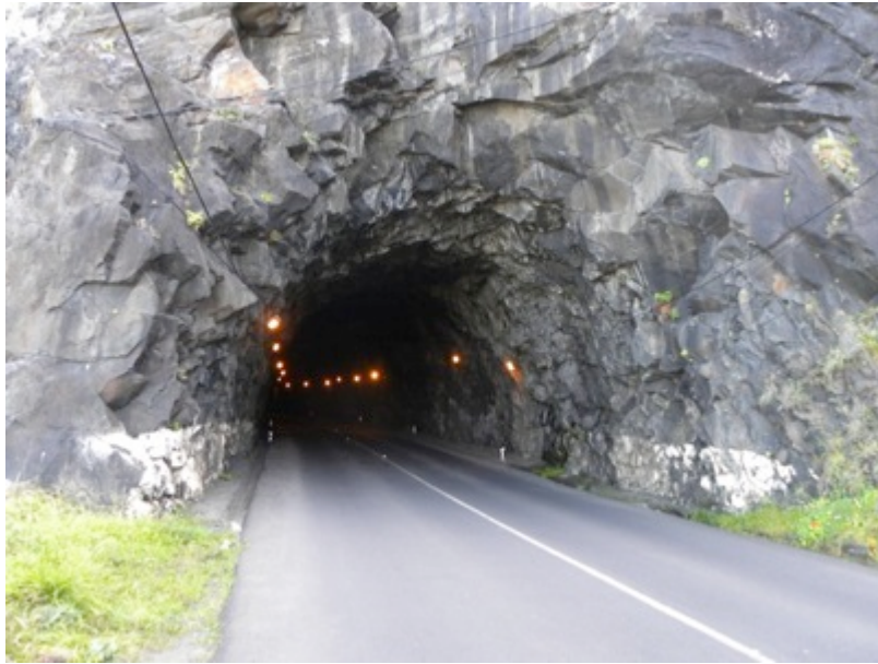
Figura 4 – Exemplo de secção em arco - Túnel Fajã da Areia, 1984
