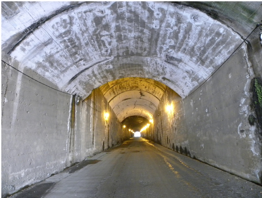
Vista para o emboquilhamento noroeste
