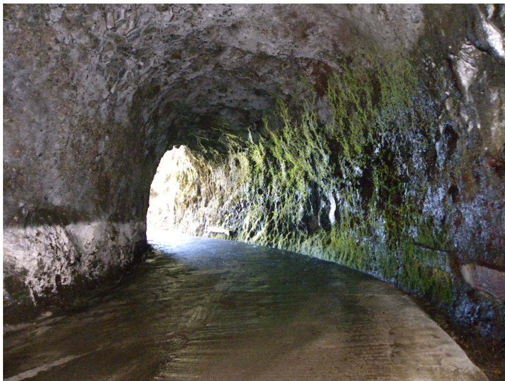
Vista para o emboquilhamento norte
