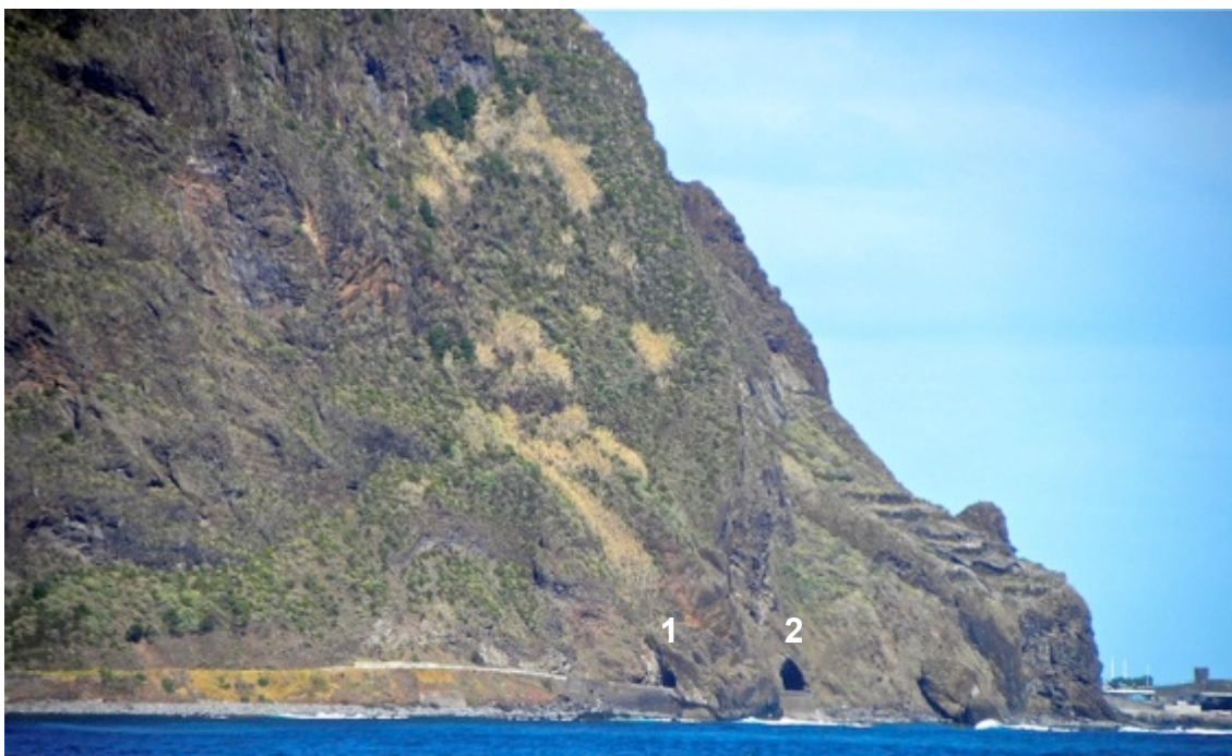
Figura 12 – Costa noroeste - Túnel Furado Pequeno (1) e Túnel Ribeira da Janela (2), 1955
