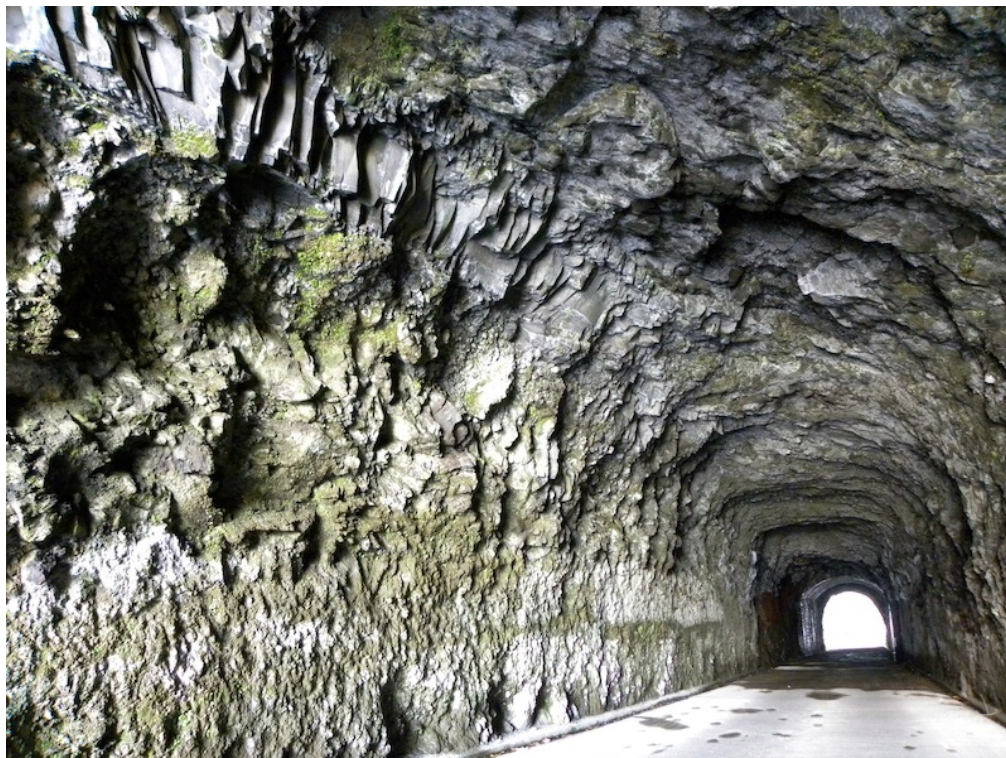
Vista para o emboquilhamento este
