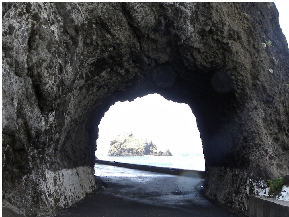
Vista para o emboquilhamento norte
