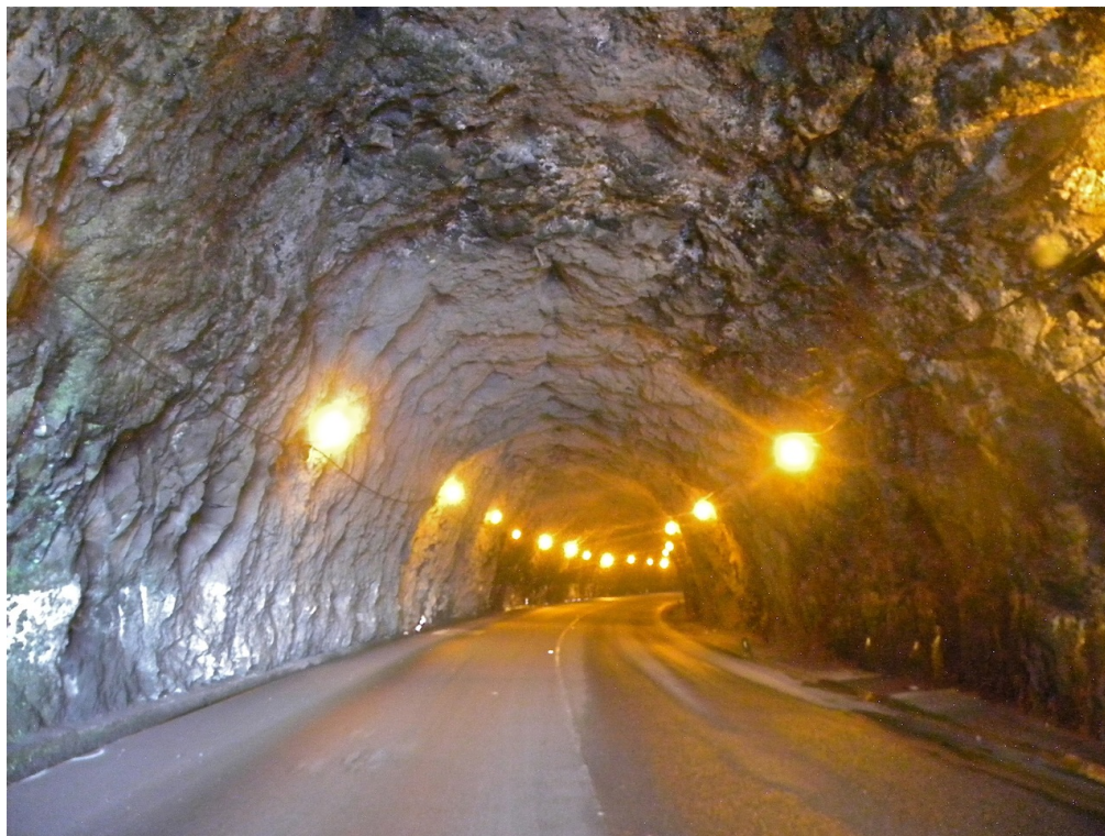
Vista para o emboquilhamento oeste
