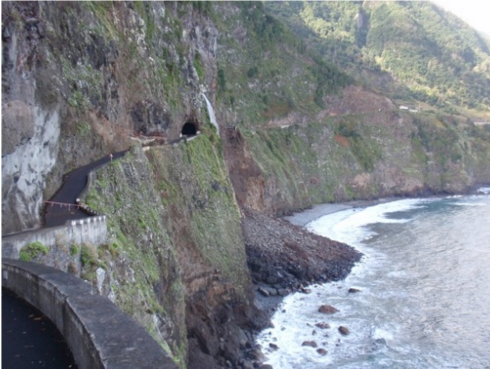
Figura 34 - Vista para oeste após derrocada de 2008 (RAMEDM, s.d.)
