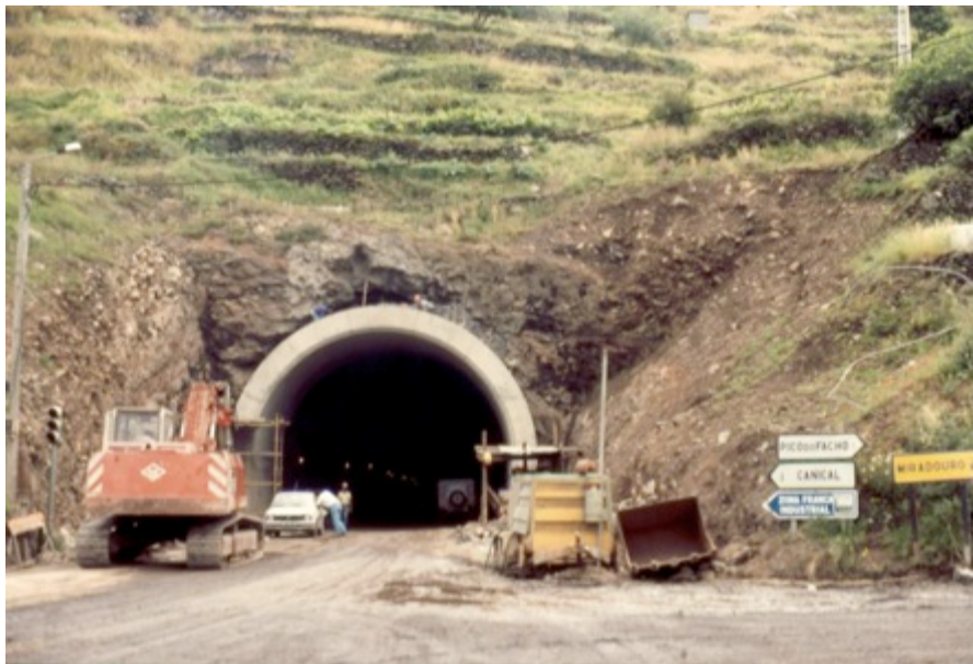
Figura 21 – Emboquilhamento sudoeste após alargamento (Cenor, 1992)
