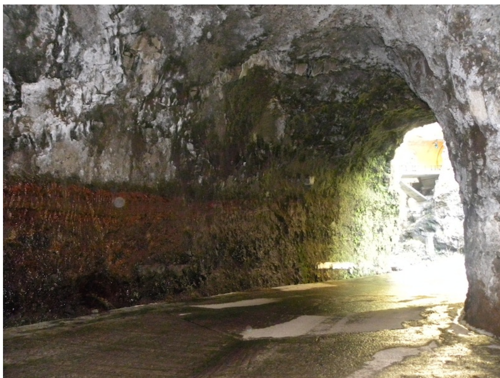
Vista para o emboquilhamento oeste
