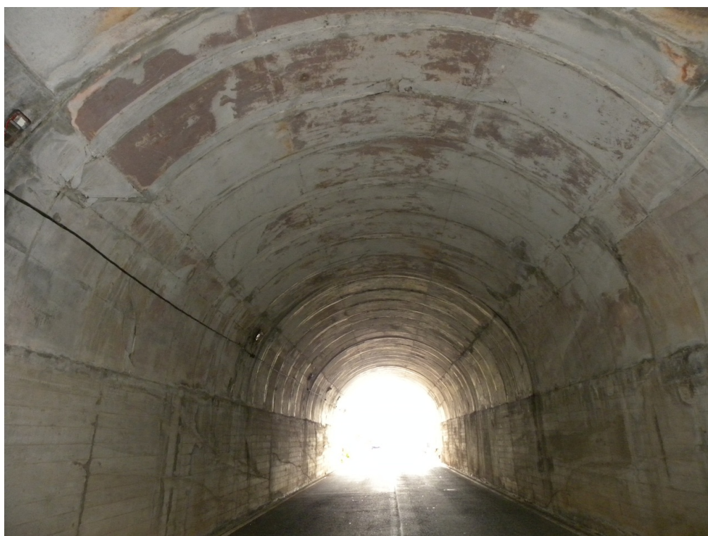
Vista para o emboquilhamento sudoeste
