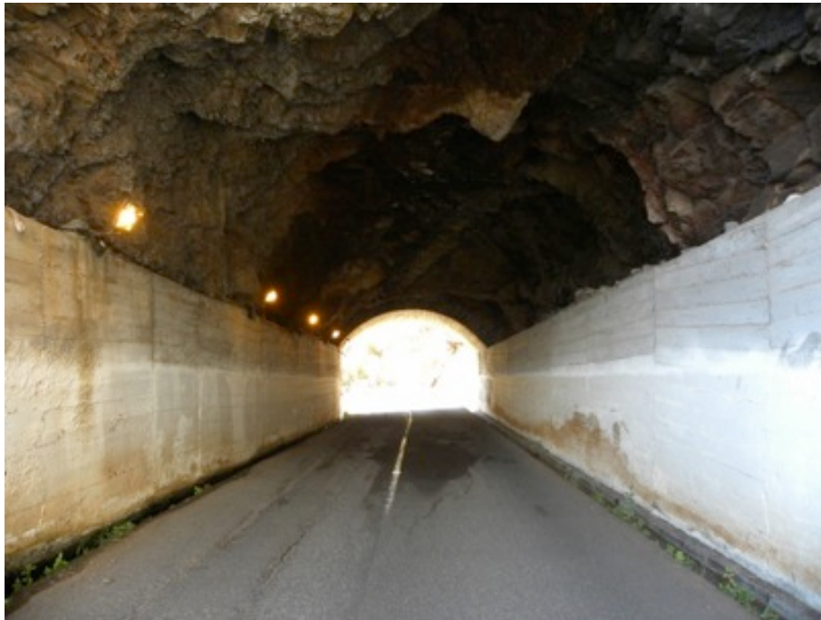
Figura 44 – Enchimento dos hasteais do Túnel III
