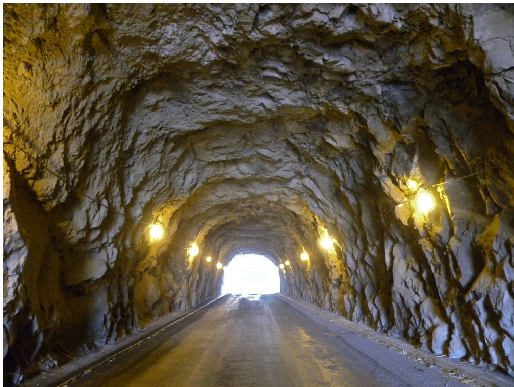
Vista para o emboquilhamento este
