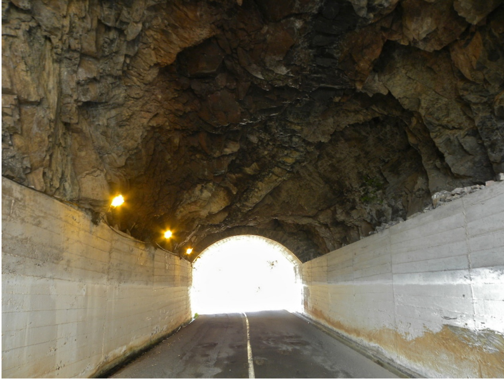
Vista para o emboquilhamento noroeste
