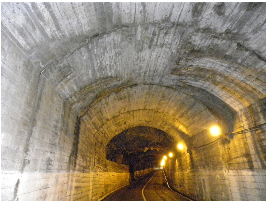
Vista para o emboquilhamento norte
