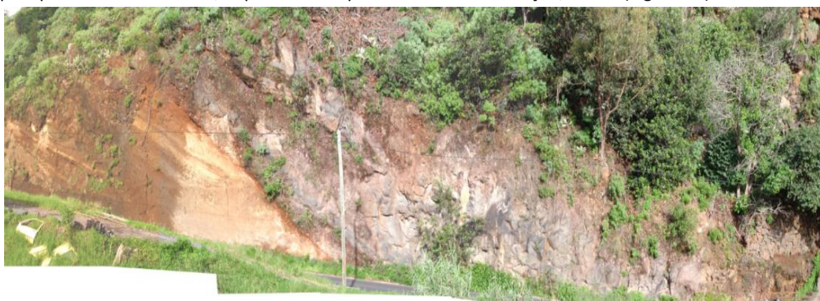
Figura 26 - Vista geral do talude B
