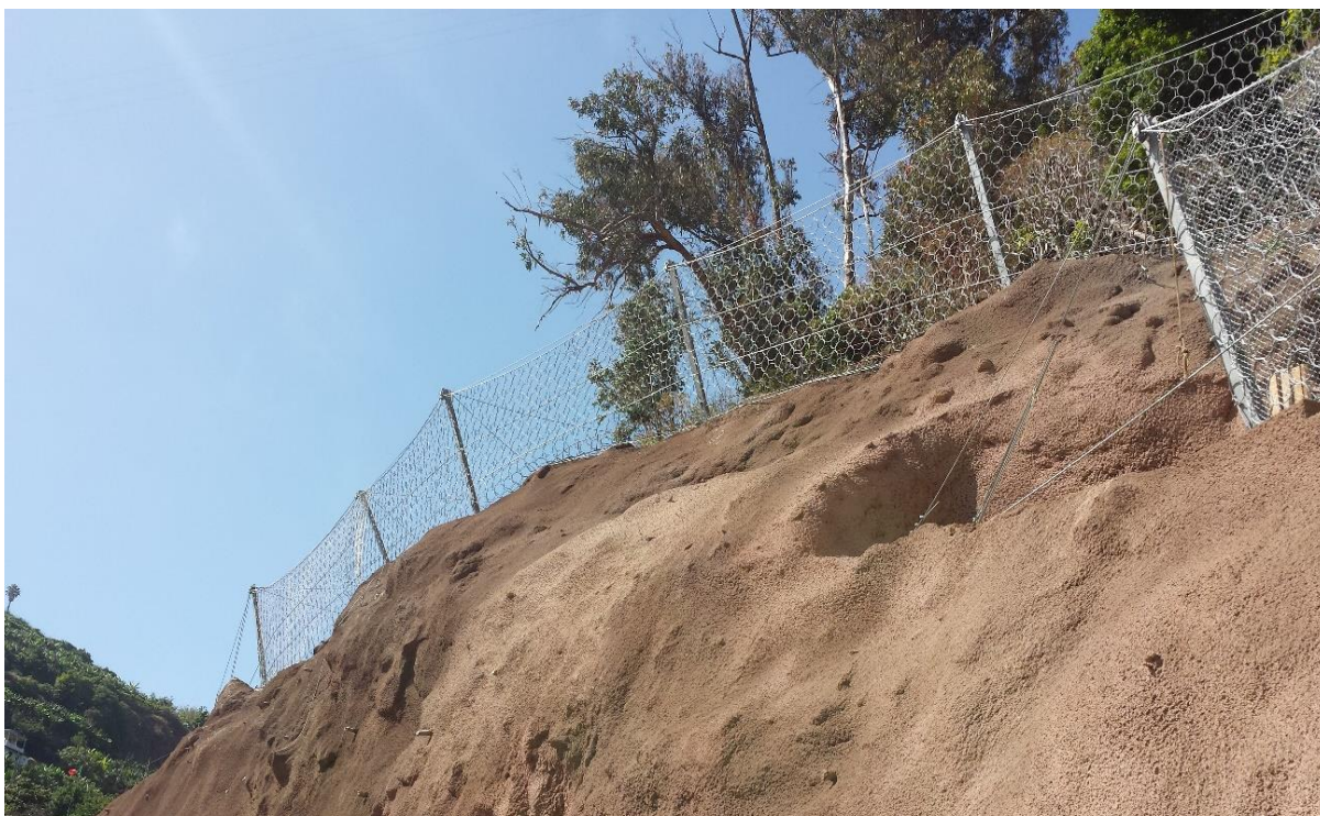
Figura 44 - Barreira dinâmica no Talude B
