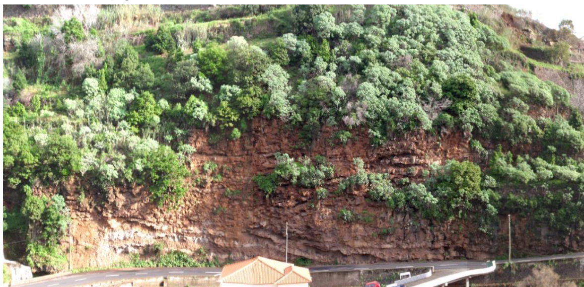
Figura 25 - Vista geral do talude A
