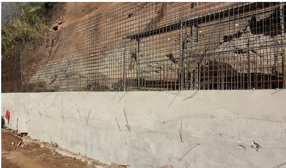
Figura 41 - Muro de suporte no topo do talude
