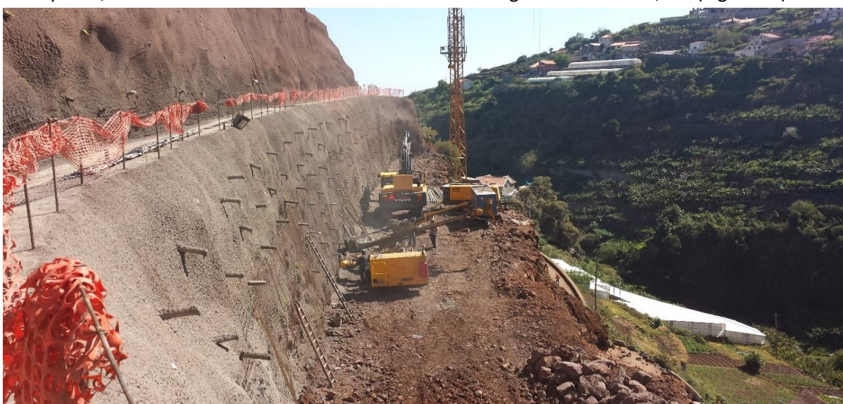
Figura 37 - Desmonte do Talude
