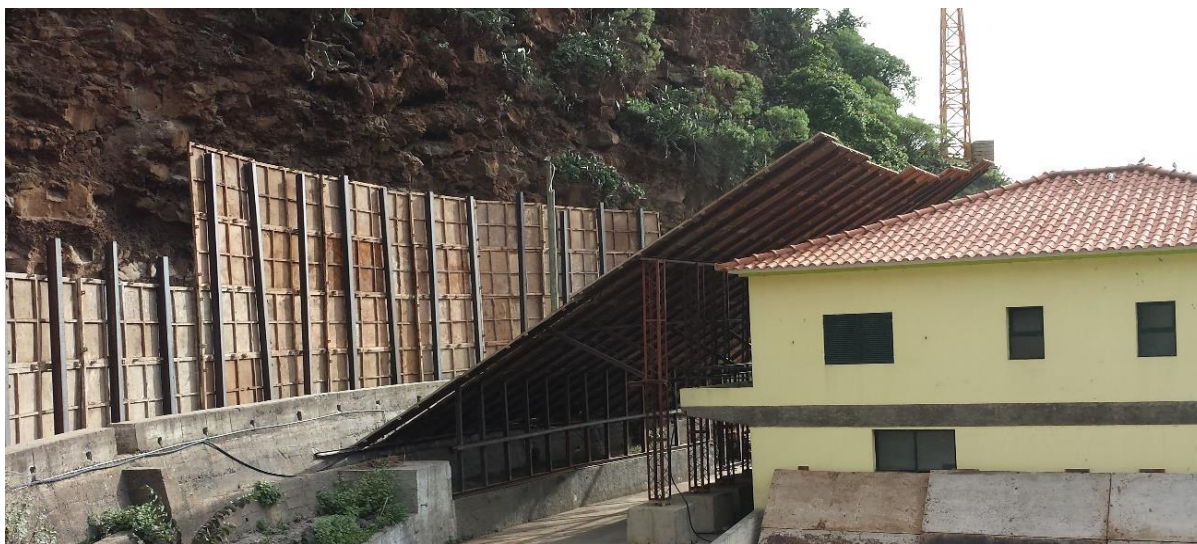
Figura 36 - Proteção colocada na berma da estrada e na habitação
