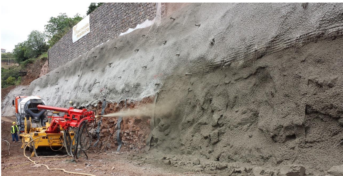
Figura 38 - Primeira camada de betão projetado, com espessura de 0,05 m
