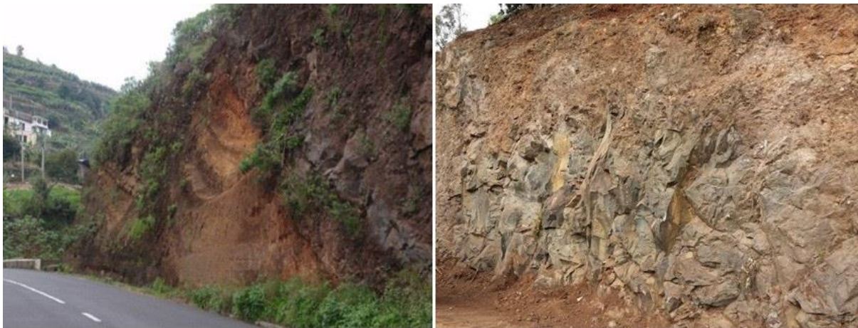
Figura 29 - Pormenor do talude B
