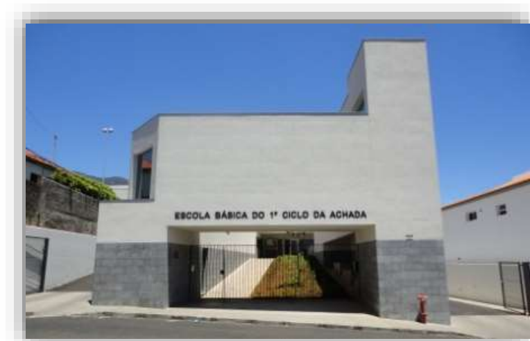
Figura 43: EB1/PE da Achada
