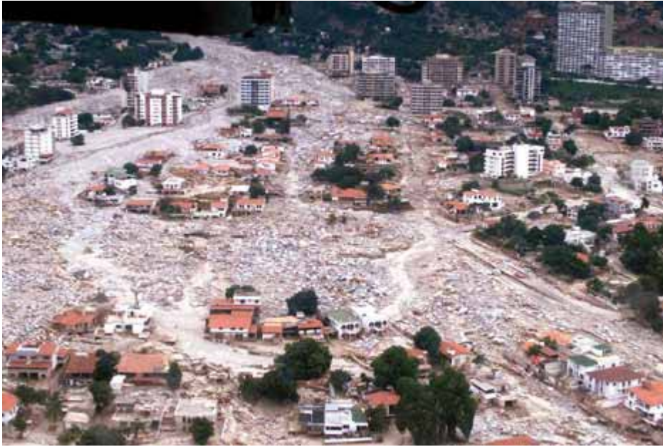
Figura 13- “Danos causados por um fluxo de detritos na cidade de Caraballeda, na base da Cordilheira de La Costan, no litoral norte da Venezuela. Em dezembro de 1999, esta área foi atingida pelo pior desastre natural do século 20; muitos dias de chuva torrencial deflagraram o escoamento de lama, torrões de solo, água e árvores que mataram aproximadamente 30.000 pessoas.” (Imagem por L. M. Smith, Waterways Experiment Station, U.S. Army Corps of Engineers). (Fonte: Highland & Bobrowsky,2008)
