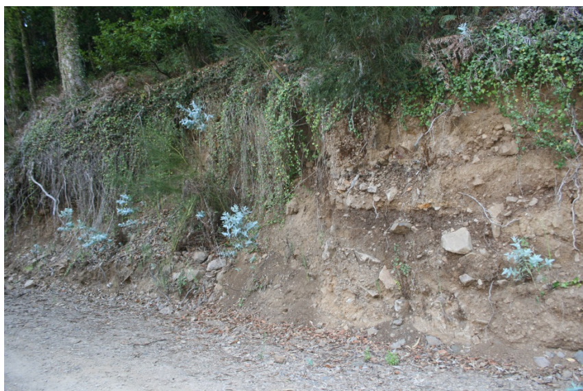
Figura 69- Local onde é pretendido efetuar o muro de suporte vivo Fonte: Foto do autor
