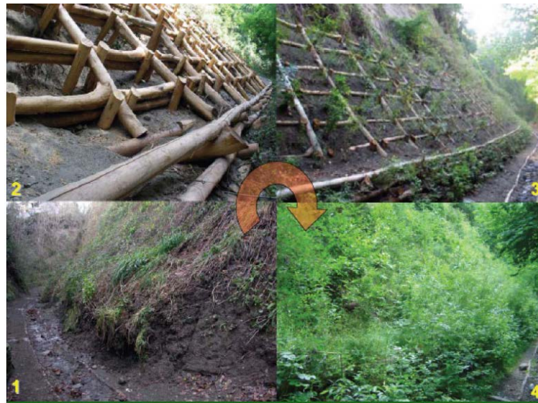
Figura 65- Fases de construção da grade viva Fonte: (AIPIN, 2002)
