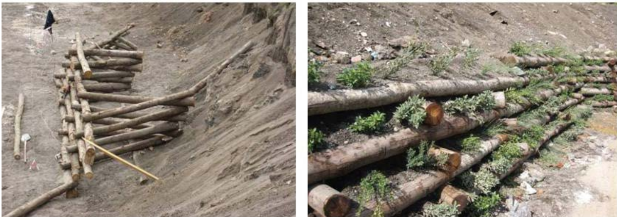
Figura 52- Muro de suporte vivo no início da construção e após a sua finalização
