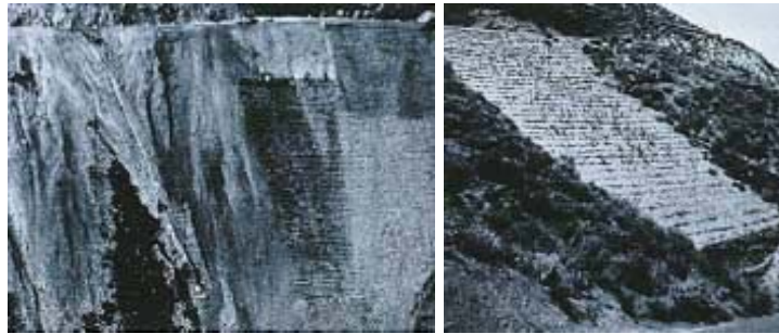
Figura 1- Instalação de fascinas vivas nos EUA em 1930 (Fonte: Lewis, 2000)
