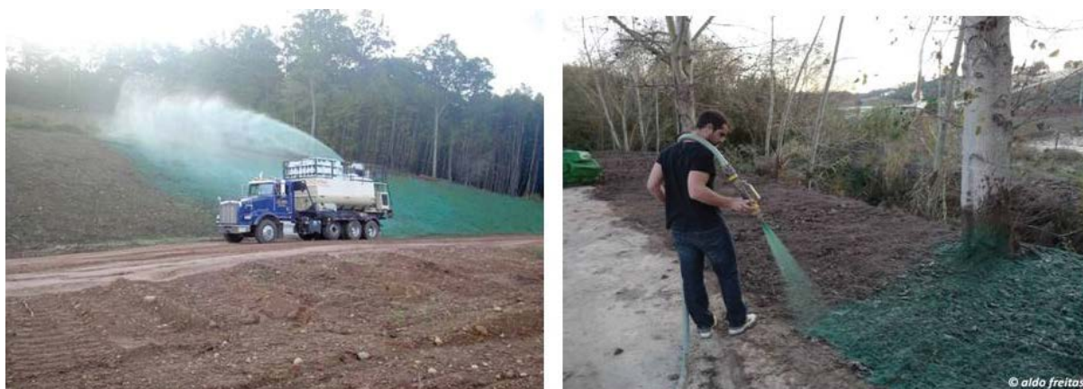
Figura 45- Hidrosementeira (Fonte: Fernandes e Freitas, 2011)
