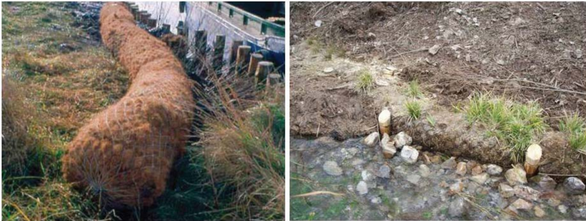
Figura 46- Biorrolos (Fonte: Fernandes e Freitas, 2011)
