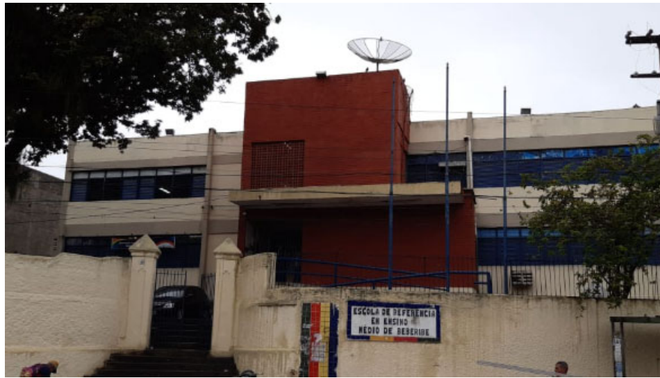
Figura 1 Imagem da escola locus da investigação
