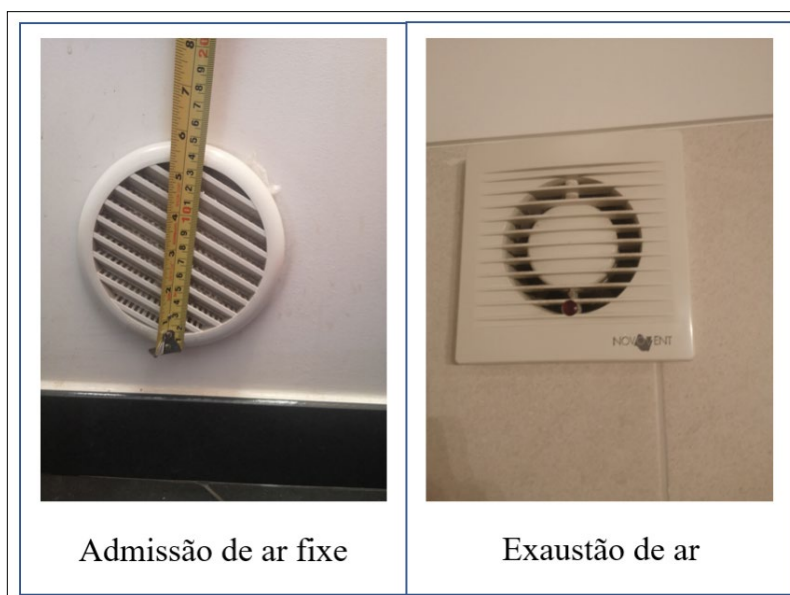
Figura A 10 - Modelo de elementos de admissão e exaustão de ar da habitação A1
