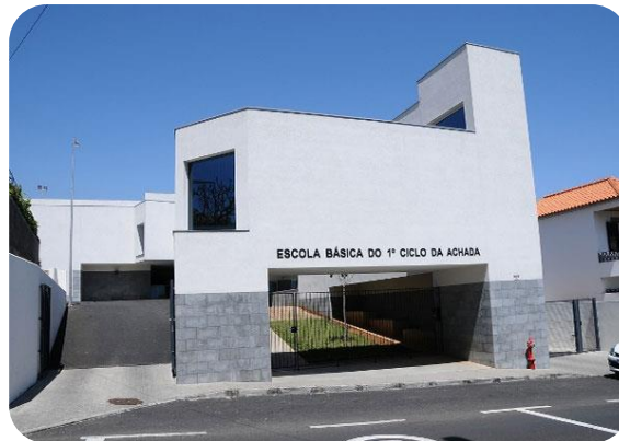
Figura 28 – EB1/PE da Achada
