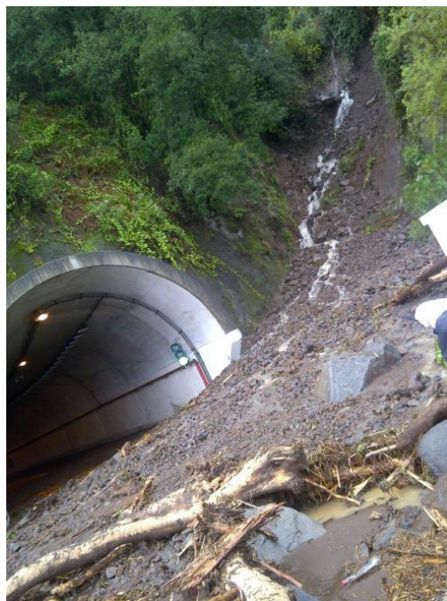
Figura 1.1 – Deslizamento de terras ocorrido na Ilha da Madeira (tvi24, 2012) [67]
