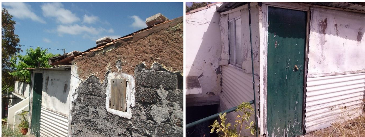
Figura 35: Paredes em estado de degradação (à esquerda) e estado de degradação das portas e janelas (à direita)
