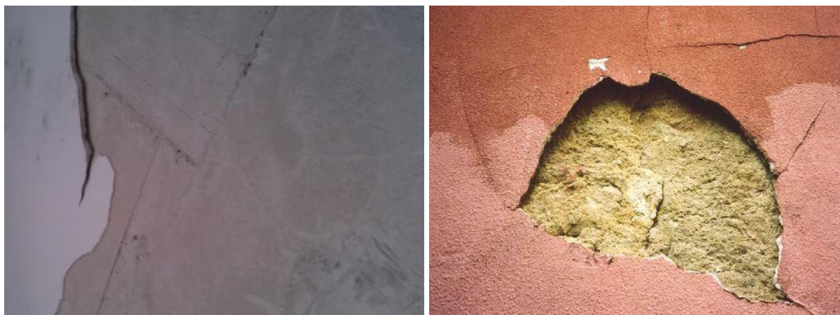
Figura 6: Suporte muito liso e com poeiras (à esquerda) e argamassa de cimento sobre camada de cal (à direita) (reproduzido de Veiga M. R., 2003)
