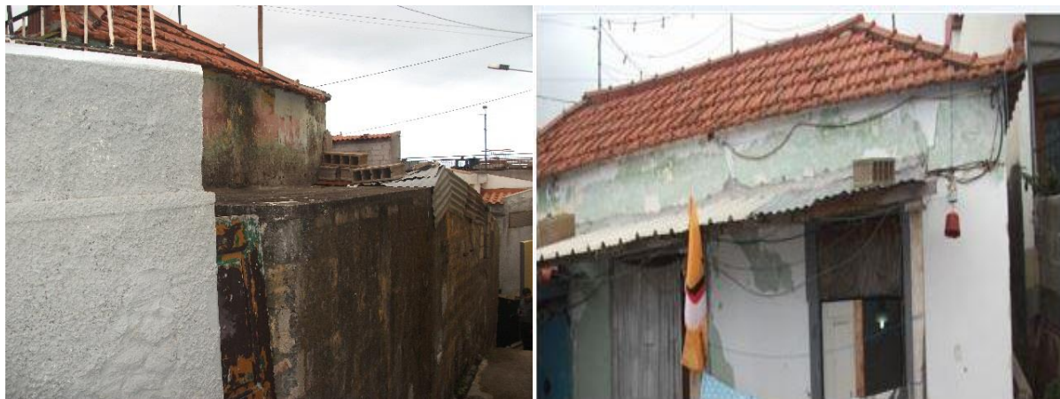
Figura 14: Cobertura em terraço (à esquerda) e cobertura em telha marselha (à direita)
