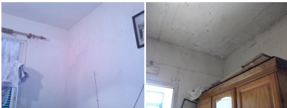
Figura 49: Estado atual das paredes e teto do quarto 1 (à esquerda) e das paredes e teto do quarto 2 (à direita)
