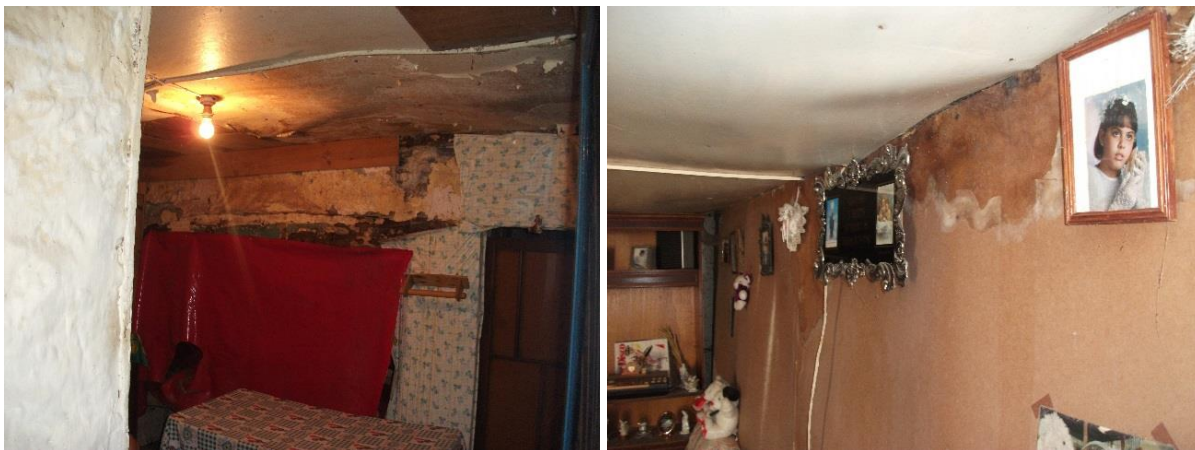
Figura 36: Estado atual da cozinha (à esquerda) e estado atual do quarto 4 (à direita)
