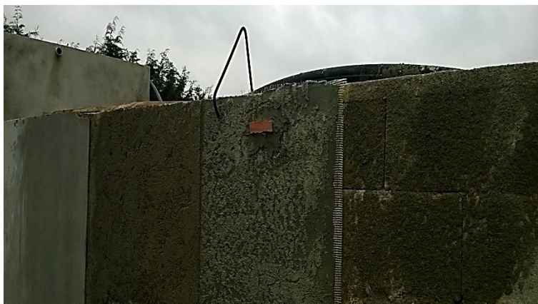
Figura 3: Solução de reboco composta por 5 camadas
