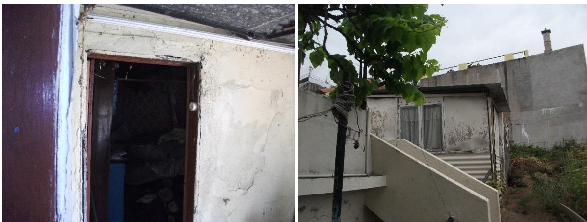
Figura 38: Estado atual da arrecadação (à esquerda) e estrutura do hall de entrada (à direita)
