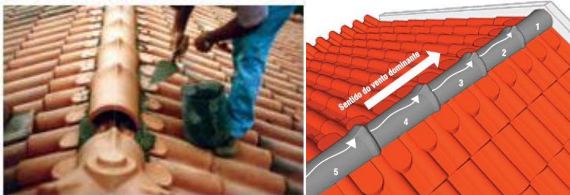
Figura 9: Assentamento de cumes sobre babadouros (à esquerda) (reproduzido de Barbosa Coimbra, 2015) e sentido do assentamento dos cumes (à direita) (reproduzido de Torreense, 2015)
