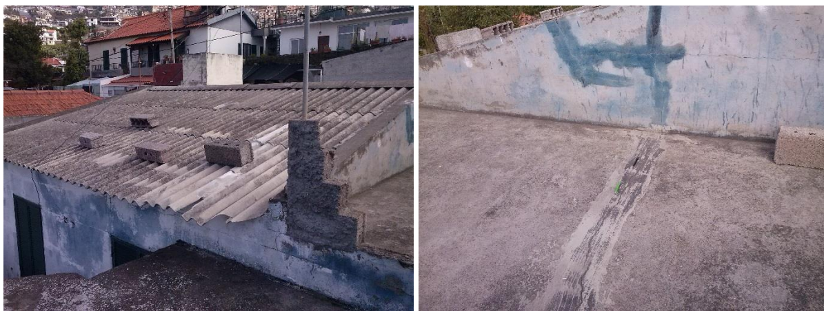
Figura 42: Cobertura em fibrocimento (à esquerda) e cobertura em terraço (à direita)
