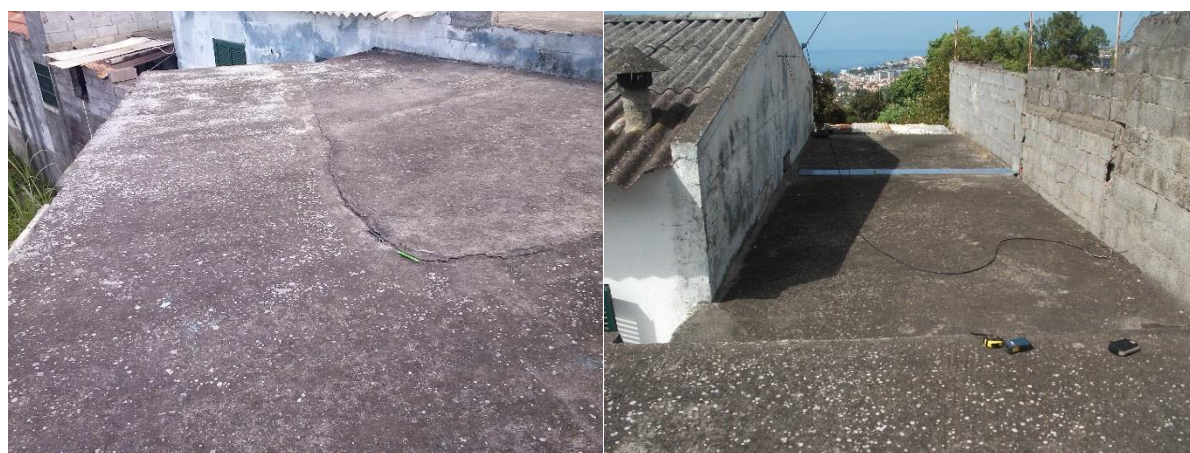
Figura 43: Cobertura do anexo lateral esquerdo (à esquerda) e cobertura do anexo lateral direito (à direita)
