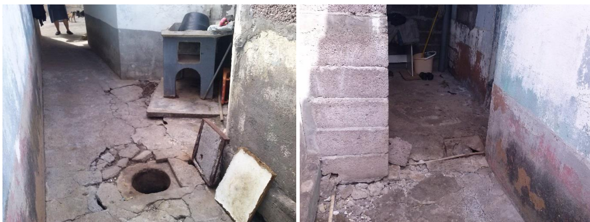
Figura 46: Pavimento entre a moradia e o anexo (à esquerda) e pavimento na entrada da arrecadação (à direita)
