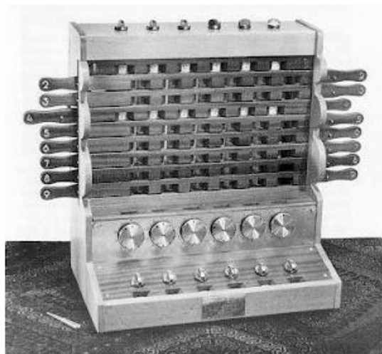
Imagem 10 – Primeira máquina de calcular (1623) do alemão Wilhelm Schickard (1592 – 1635) capaz de somar, subtrair, multiplicar e dividir.
