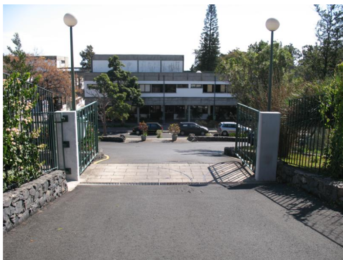
Imagem 31 – Uma das entradas da Escola Básica e Secundária Gonçalves de Zarco – Fotografia do autor
