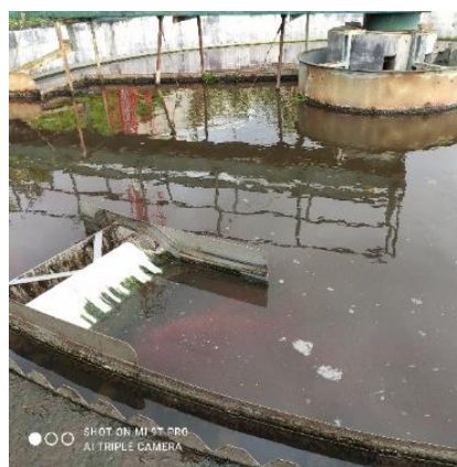
Figura 5 - ETAR de Gaula: Decantador secundário Fonte: Elaboração própria
