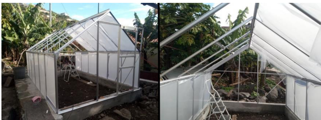
Figura 22. Montagem das placas na estrutura.
