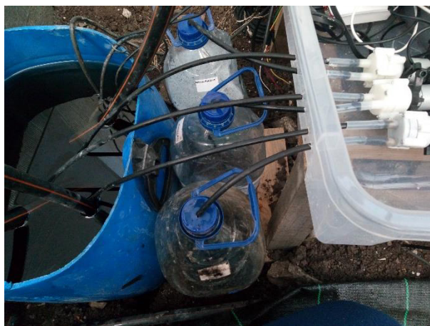
Figura 47. Sistema de doseamento - parte dos depósitos de nutrientes e do poço da solução aquosa.
