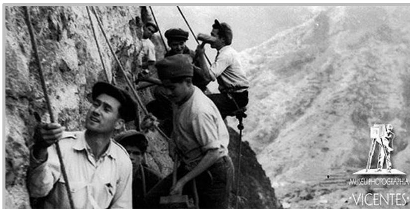
Figura 8. Trabalhadores na construção de uma levada (Museu Photographia Vicentes)
