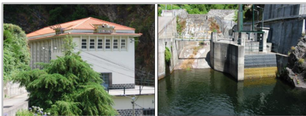
Figura 12. Central Hidroelétrica da Serra de Água (retirado do site da Empresa de Eletricidade da Madeira)
