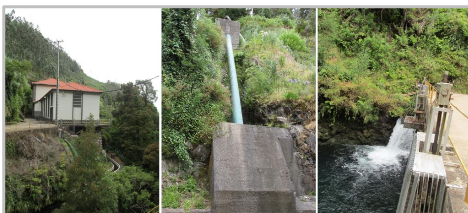
Figura 21. Central Hidroelétrica da Calheta
