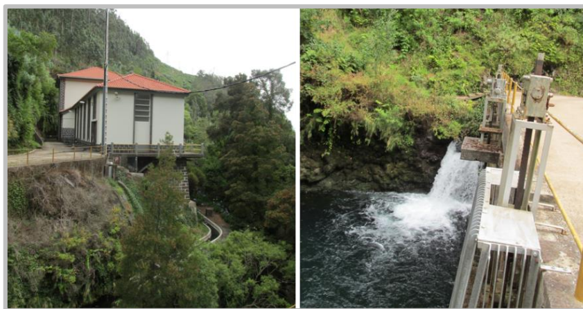
Figura 13. Central Hidroelétrica da Calheta
