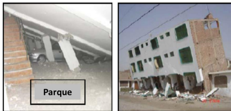
Figura 2-15. Colapso do primeiro piso de um edifício de alvenaria confinada após o sismo de 2007 em Pisco, Perú (Meli e Brzev (2011)).
