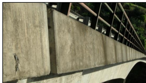
Figura 2-11 Pormenor de cornijas na Ponte do Vigário
