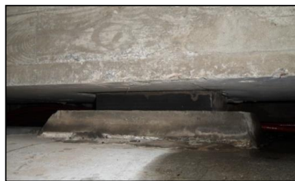
b. Tipo neoprene, na ponte do Porto Novo
