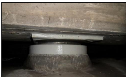
a. Tipo panela, na ponte João Gomes
