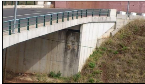
Figura 2-9 Encontro oeste na Ponte dos 3 Paus
