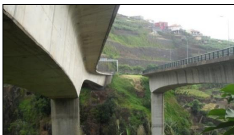
Figura 2-8 Tabuleiros e apoios intermédios na Ponte do Vigário
