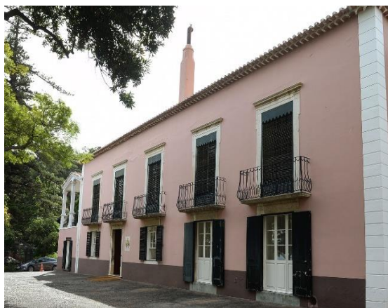
Figura 127 -Edifício principal da Quinta Vigia. Fonte: Miguel Dantas
