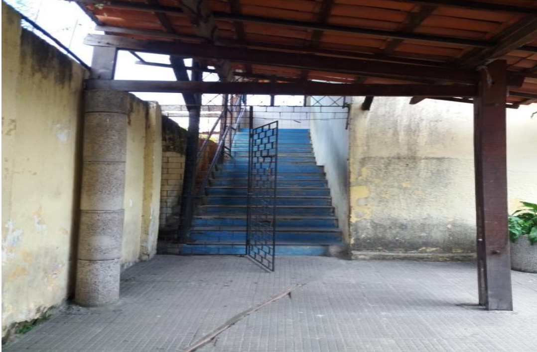
FOTO 5 - ESCADA DE ACESSO PARA O 1º ANDAR
