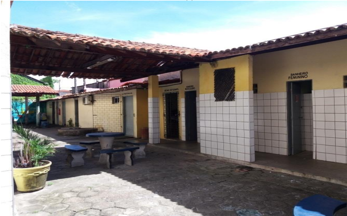
FOTO 15 - 2º PAVILHÃO LADO DIREITO (2)
