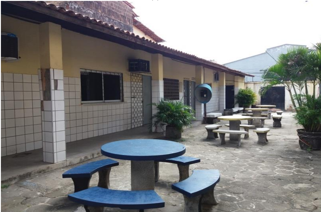
FOTO 14 - 2º PAVILHÃO LADO DIREITO (1)
