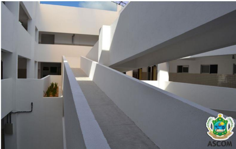
Foto 02: estrutura interna da escola – rampa de acessibilidade
